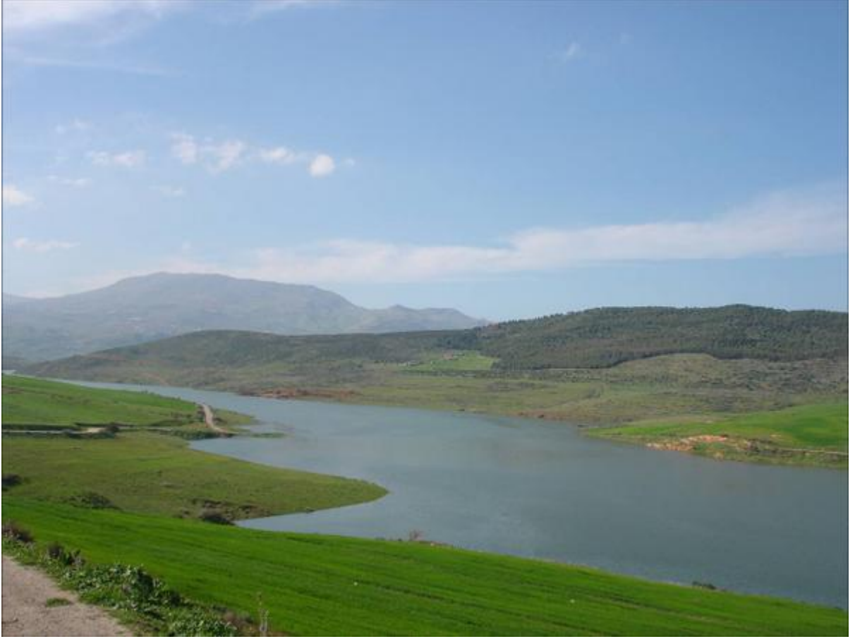
صورة رقم (17): بداية عملية غمر الأراضي بمياه سد بني هارون
