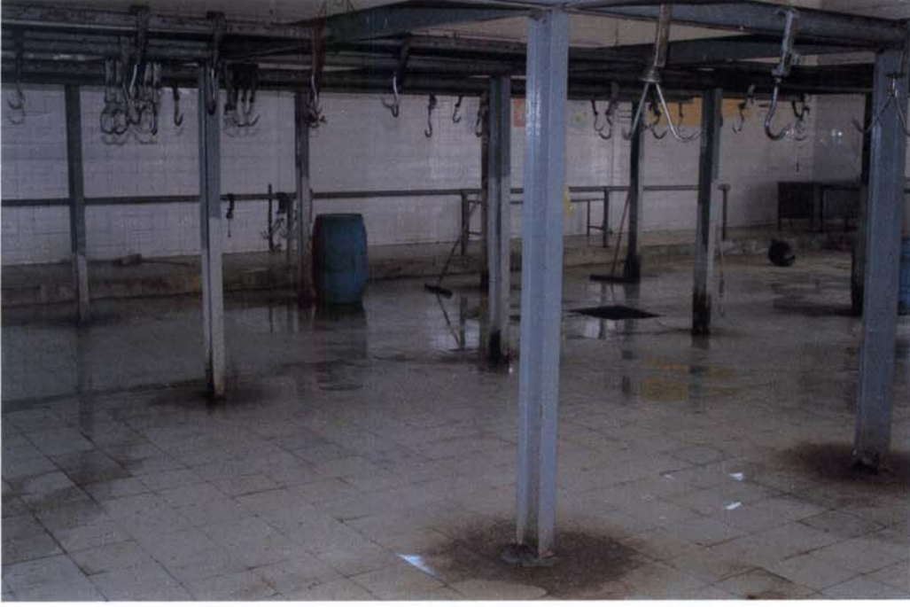
شكل رقم (٢٠) يوضح صالة الذبح الضيقة والأعمدة الحديدية المتهالكة وضالة الإمكانيات بمسلخ الوادي بالجموم.
