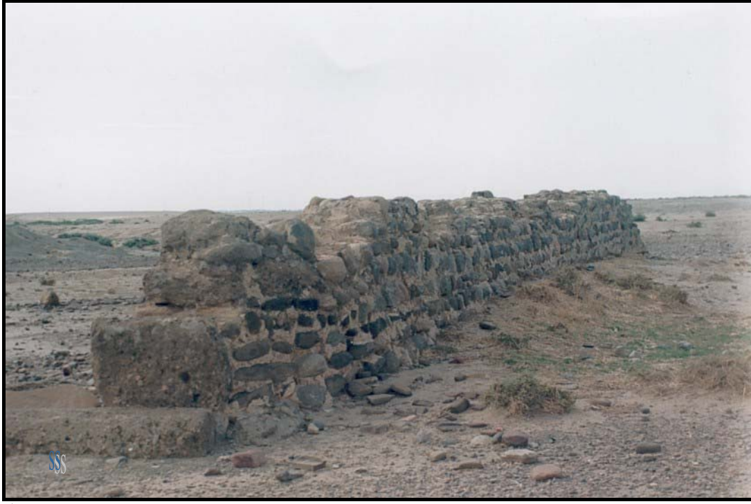
الصورة رقم 39 ج- الحجارة الضخمة المدعمة للجدار الحامل للقناة
