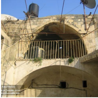
شكل (4-38) الشقوق والشروخ داخل المبنى. شكل (4-39) مشاكل انتشار الرطوبة. شكل (4-40) التشوهات المعمارية بسبب التمديدات. المصدر: محمد والرملاوي، 2010 المصدر: السابق المصدر: منتديات معماري، 2012
