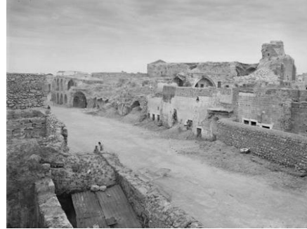
شكل (4-7) الدمار الذي لحق بغزة بسبب القصف البريطاني في مارس وإبريل من عام 1917. المصدر: فلسطين في الذاكرة، 2013
