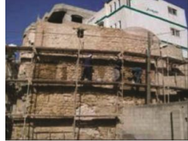
شكل (4-41) أعمال الترميم في الواجهة الشمالية
