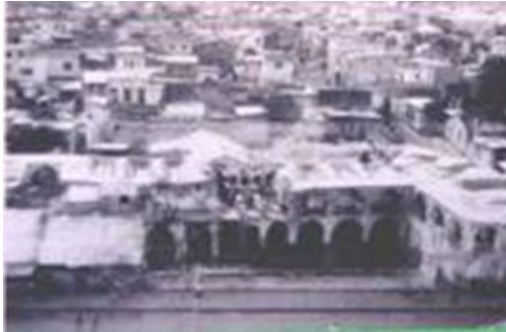
شكل (4-9) مبنى خان الزيت (مكان عمارة أبو رحمة حاليا) المصدر: فلسطين في الذاكرة، 2013
