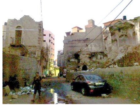
شكل (5-14) هجر المباني الأثرية وتهدمها وانتشار البناء الحديث المصدر: السابق
