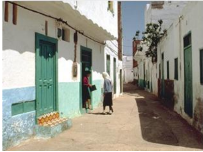
شكل(3-23): المباني المتهاكلة والشوارع غير المبلطة في مدينة أصيلة قبل الحفاظ. المصدر: السابق
