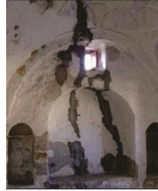
شكل (4-38) الشقوق والشروخ داخل المبنى. شكل (4-39) مشاكل انتشار الرطوبة. شكل (4-40) التشوهات المعمارية بسبب التمديدات. المصدر: محمد والرملاوي، 2010 المصدر: السابق المصدر: منتديات معماري، 2012
