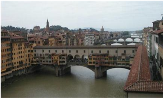
شكل (3-7) Ponte Vecchio في فلورنسا رغم حداثة الإضافة، تتجانس وتتكامل مع التكوين العام المصدر: (المغني، 2012)
