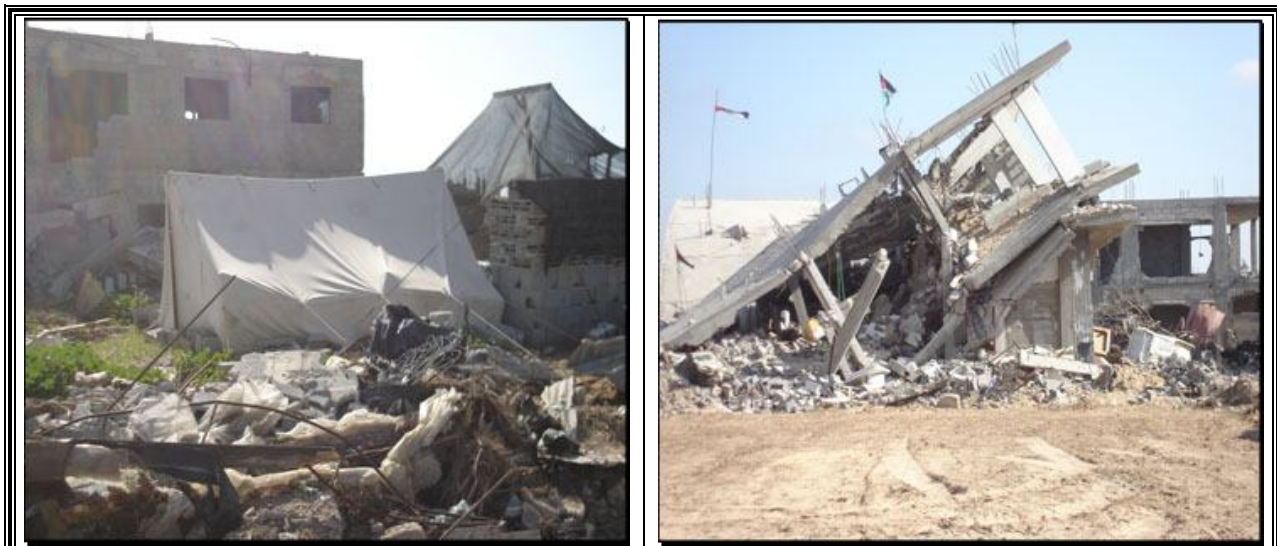
صورة رقم (2.4) صور متنوعة لشكل المباني المدمرة في القرية
