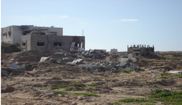
صورة رقم (49.5) الجرافات الاسرائيلية تجتاح المنطقة
