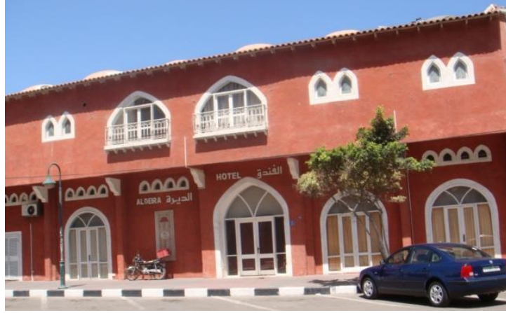
شكل توضيحي 16-5 الواجهة الخارجية لمطعم و فندق الديرة
