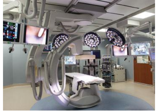
شكل رقم (٣-٢٥): صورة توضح بعض مكونات غرفة العمليات الهجينة
