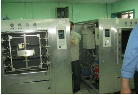
شكل رقم ( ٢٧-٤ ) صورة توضح أجهزة التعقيم بالقسم
