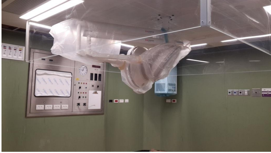
شكل رقم (٦٣-٣) صورة توضح نظام التدفق الصفائحي ( مبنى مستشفى الجراحات التخصصية) المصدر: الباحثة
