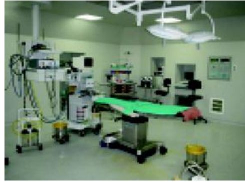
صورة (٣-٨): داخل غرفة عمليات المصدر: S.K. Gupta, S. Kant, R. Chandrashekar, 2005
