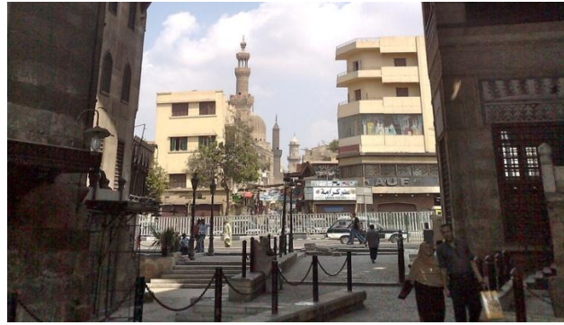
شكل (1.4): المباني الحديثة والتشوه المعماري داخل الدرب الأحمر بالقاهرة الفاطمية (AKDN، 2013)
