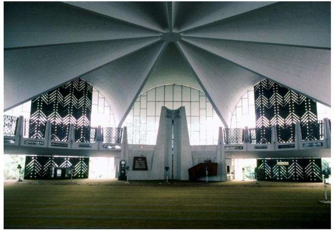
شكل (٣-١٣٥) صورة توضح أسلوب التغطية السقف على شكل قطع زائدة مقعرة من الخرسانة المسلحة.
