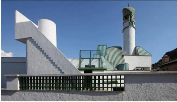
شكل (٣-١٤٨) صورة توضح أسلوب التغطية السقف على شكل قطع زائدة مقعرة من الخرسانة المسلحة.
