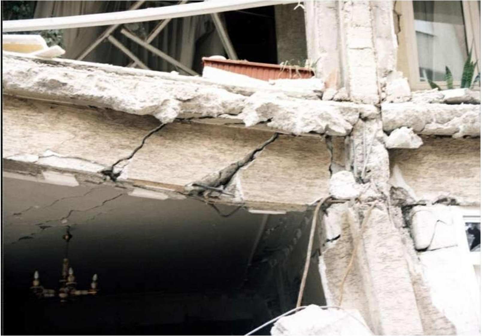
شكل رقم (3): انهيار كامل للكمرة نتيجة زيادة الاحمال ويظهر في الشكل شكل الانهيار القصي.
