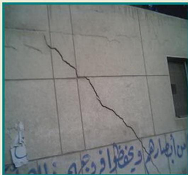
هبوط غير متساوي يؤدي إلى ظهور تشققات أو شروخ بالحوائط
