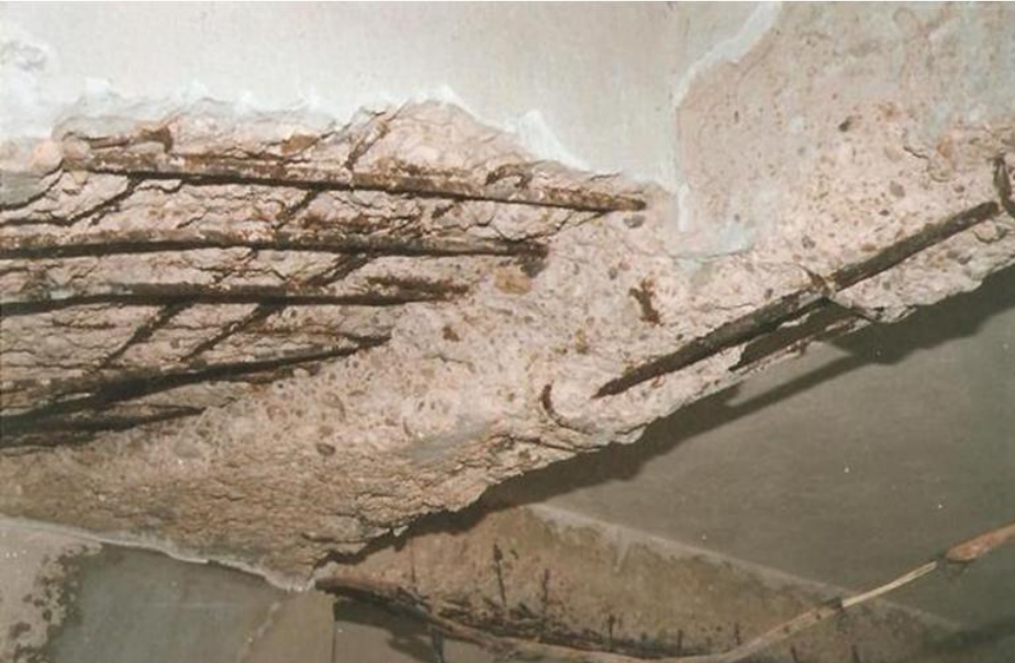
شكل رقم (1): صدأ حديد التسليح بكمره وبلاطة السلم مع سقوط الغلاف الخرساني.
