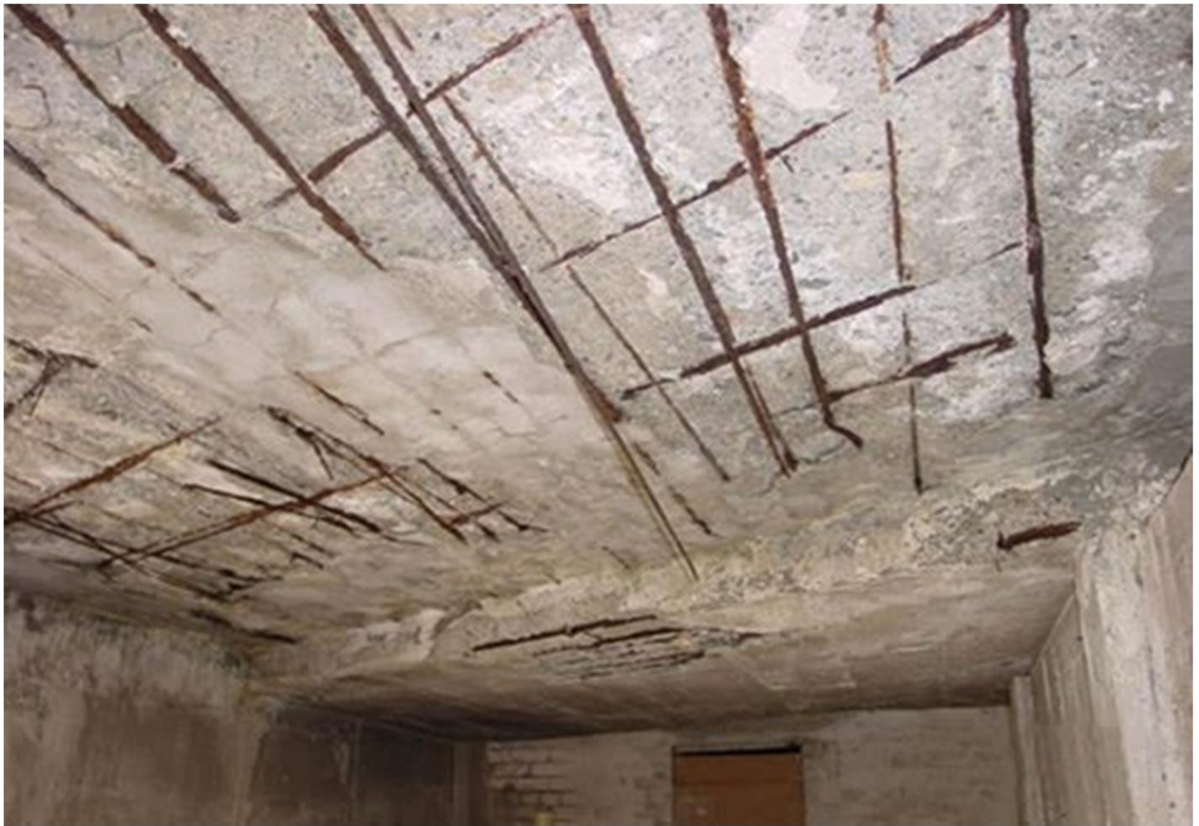
شكل رقم (2): صدأ حديد التسليح في بلاطة السقف مع سقوط الغلاف الخرساني.
