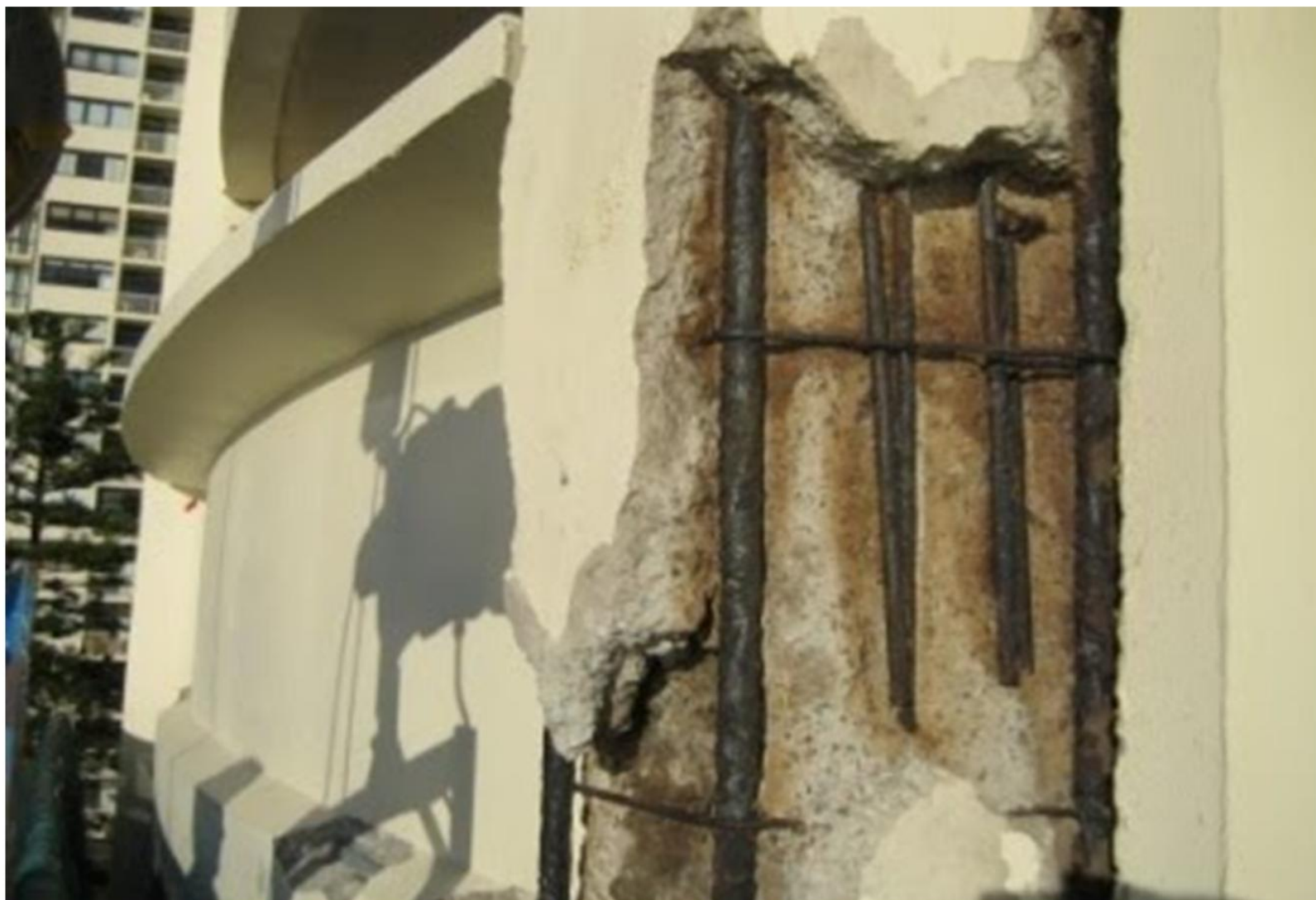
شكل رقم (4): صدأ حديد التسليح في عمود خرساني.
