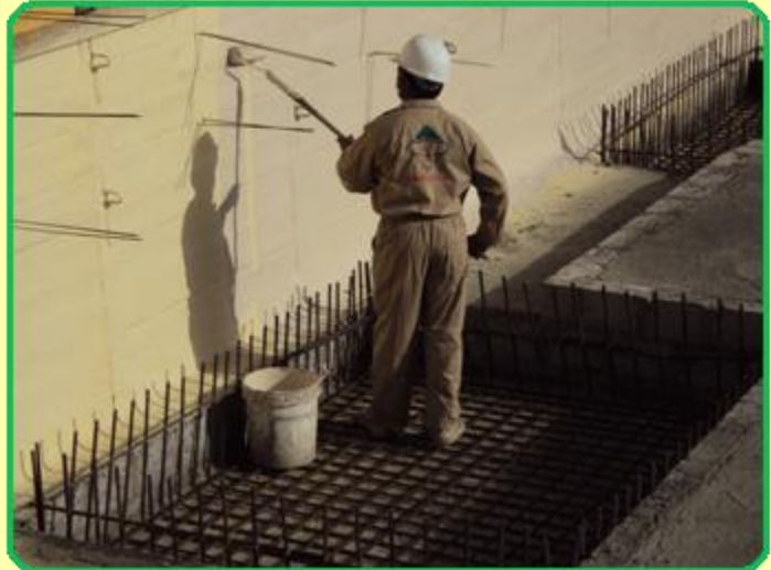
الصورة توضح عزل حوائط التدعيم بمراحلها المتخلفة .
