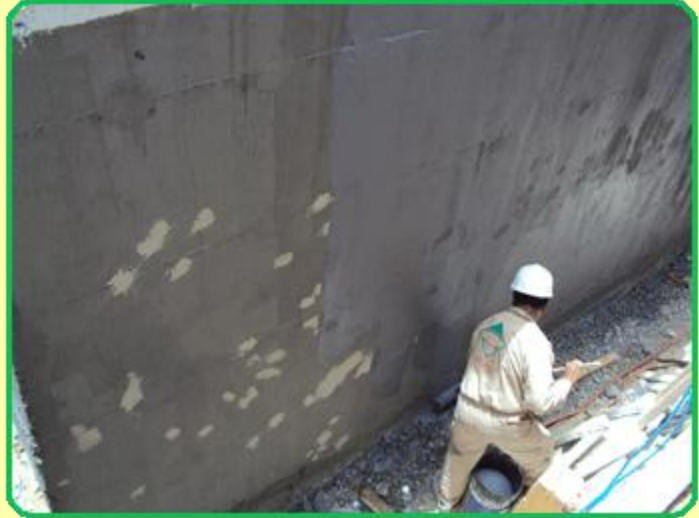
الصورة توضح طريقة العزل للحائط بالبدروم.
