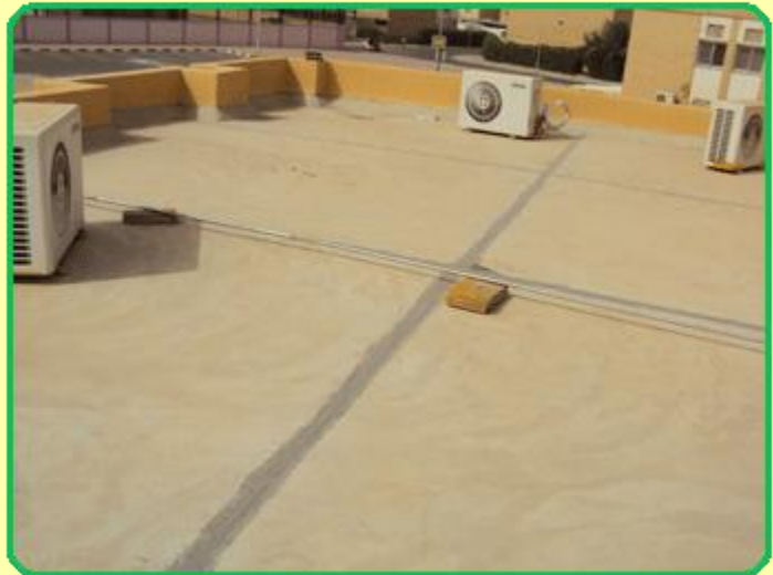
الصورة توضح فواصل التمدد في الأسطح .
