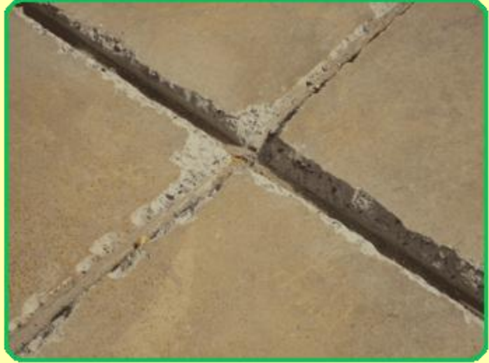
الصورة توضح فاصل تمدد تم وضع قضيب أسفنجي فيه تمهيداً لتعبئة المعجون .
