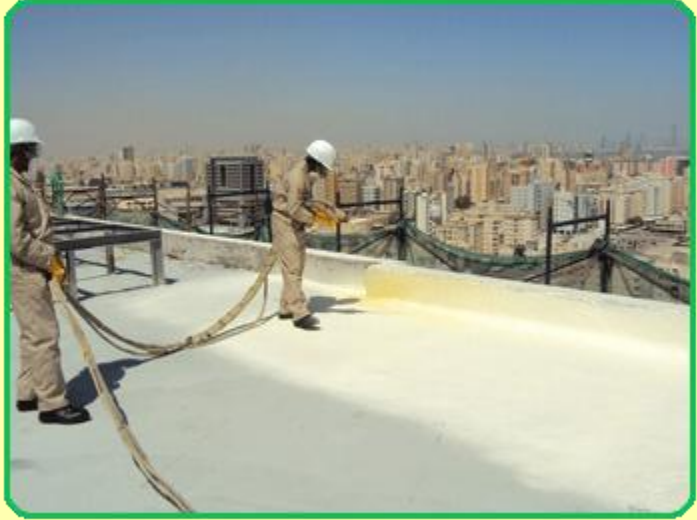
الصورة توضح عزل السطح و الدروة.
