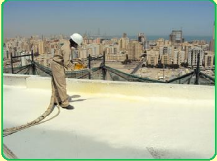
الصورة توضح طريقة عزل الدروة مع السطح .
