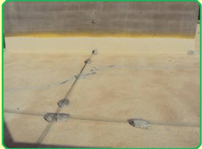
الصورة توضح الأوتار قبل صب خرسانة بالسطح .
