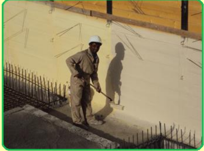
الصورة توضح حائط التدعيم بالبدروم تم عزله بطريقة الرش بالبولي يورثين .
