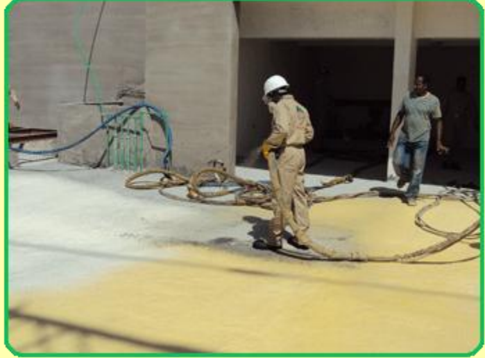
الصورة تبين البدء بأعمال رش العازل المائي والحراري ( البولي يورثين ) .
