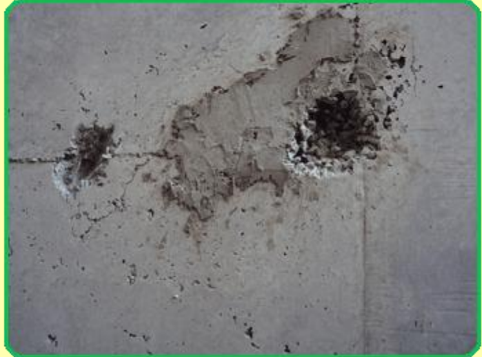
الصورة توضح أماكن الخرسانه الضعيفة قبل العزل بحوائط البدروم.
