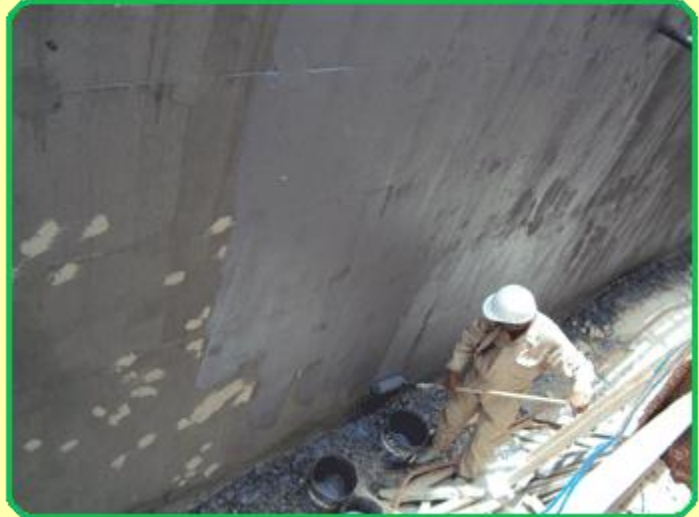
الصورة توضح طريقة العزل للحائط بالبدروم.
