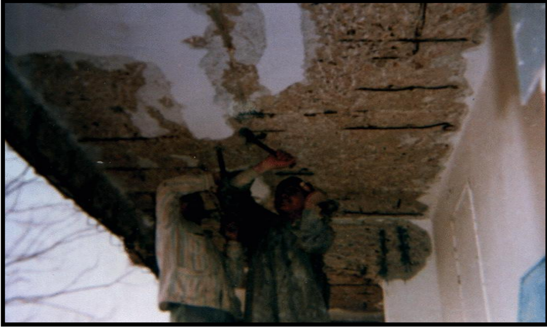
ازالة الغطاء الخرساني للكشف عن صدأ الحديد
