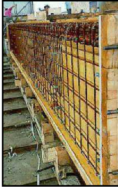
تجميع القوالب لكمرة من الخرسانة سابقة الصب
