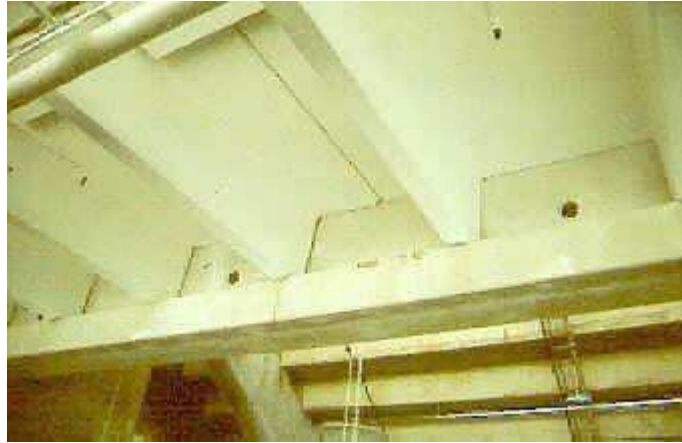
سقف من البلاطات شكل \Pi والكمرات سابقة الصب
