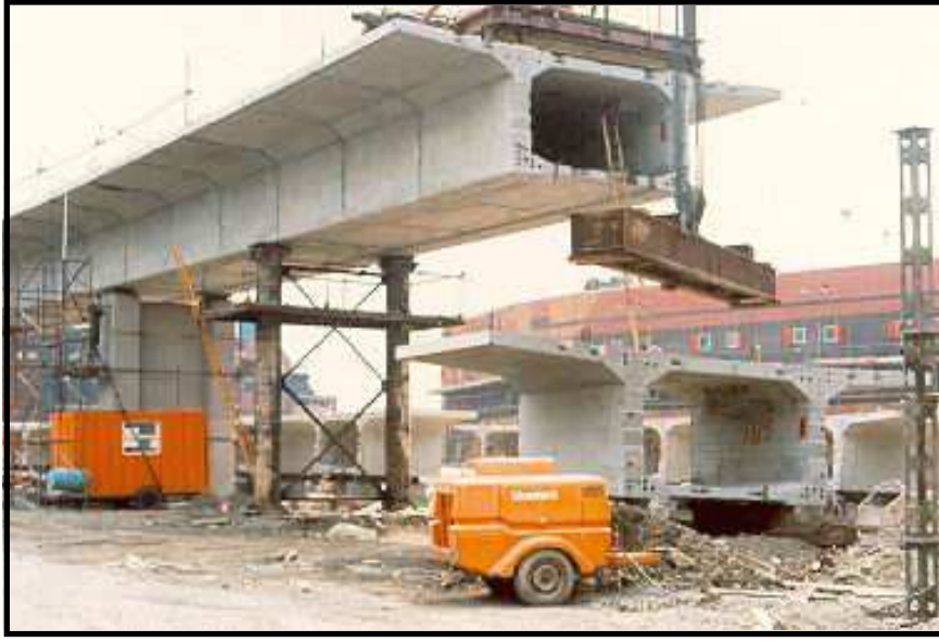
خرسانة سابقة الصب في الموقع Site Precast
