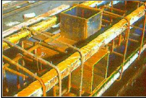
تجهيز الجزء المعدني البارز Steel insert داخل القفص الحديدي للعمود قبل صبه.
