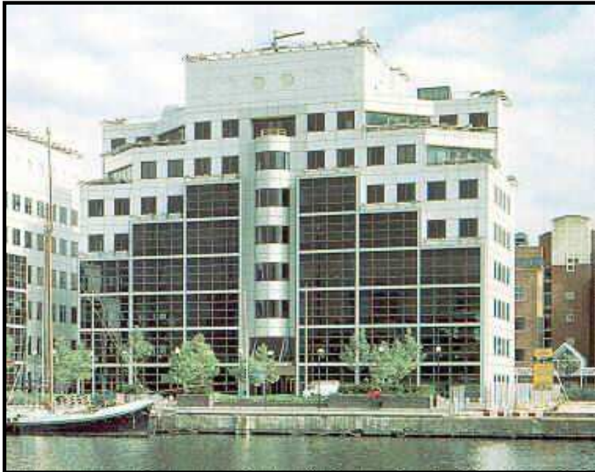
منشأ من الخرسانة سابقة الصب بعد تشطيبه به أجزاء من الهيكل ظاهرة وأجزاء مختفية
