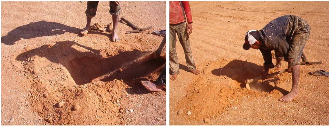
يتم عمل حفر الاختبارات المكشوفة يدوياً باستخدام بعض الأدوات المستخدمة باليد
