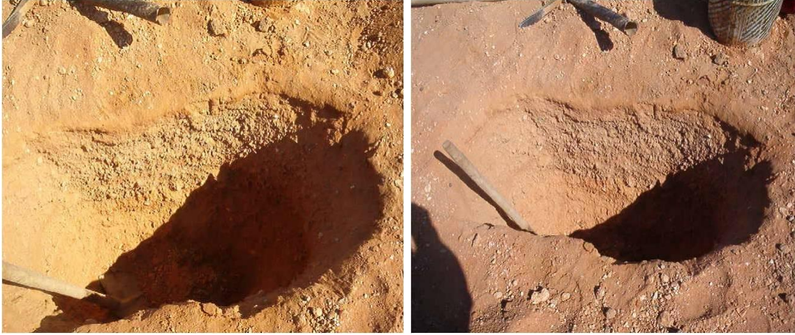
حفر الاختبارات المكشوفة Test Pits and Open Cuts
