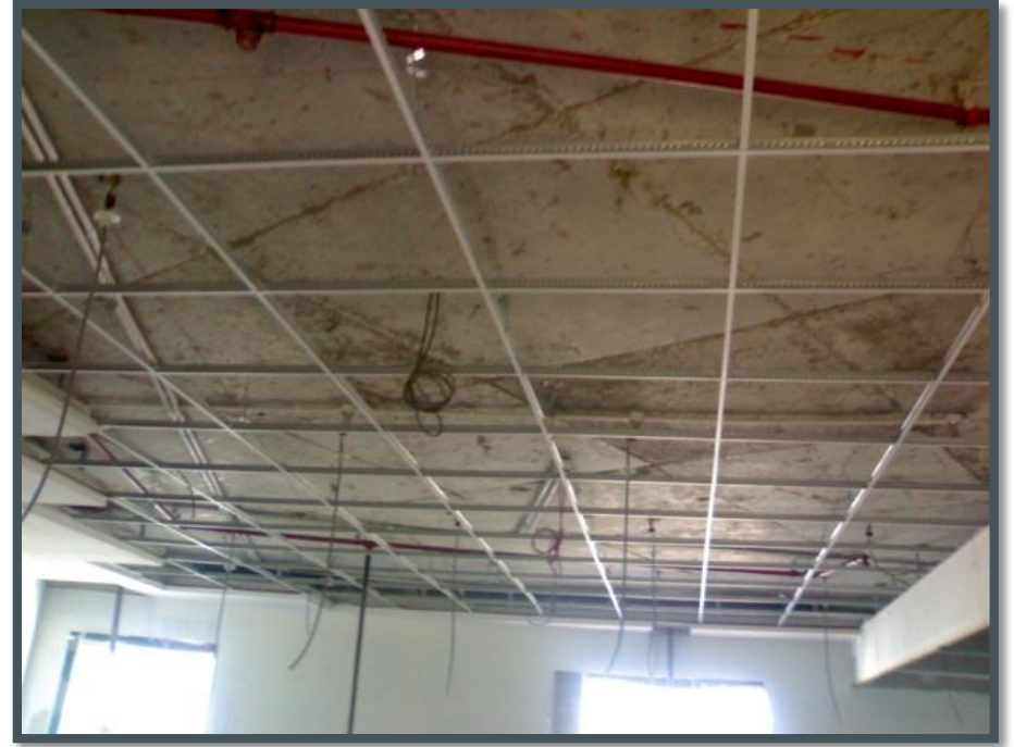
عمل الشبكة التي تثبت عليها البلاطات
