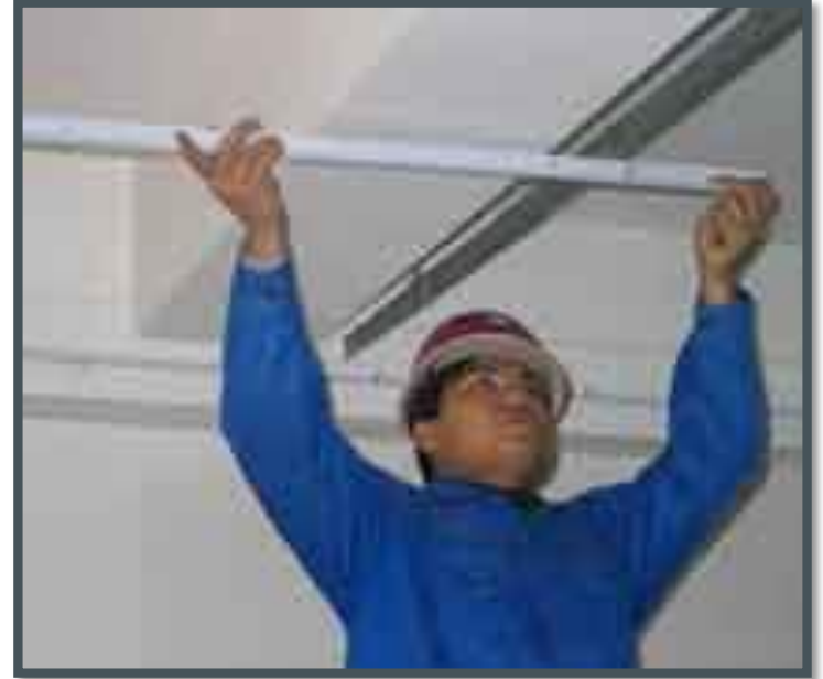
تجهيز السقف ورسم ال Grid 60x60 البداية من المنتصف وأخذ المقاسات الصحيحة
