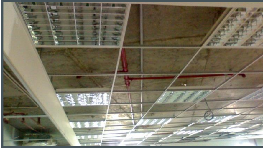
هذه اماكن الأضاءه التي توجد في السقف المعلق
