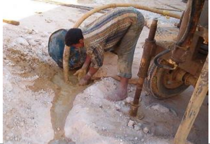
7- ربط فدية القطع في ماسورة الكور لأستخدامها في الحفرة واخذ العينات التي تدخل للكور
