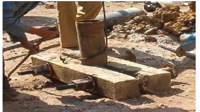
9- لمنع تهيب التربه اثناء الحفر يتم وضع مواسير السند وتثبيتها بالزرجينه
