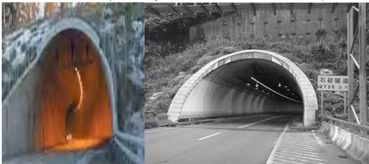
الشكل رقم (٤١) يوضح شكل محيط النفق من الداخل كالجبل
