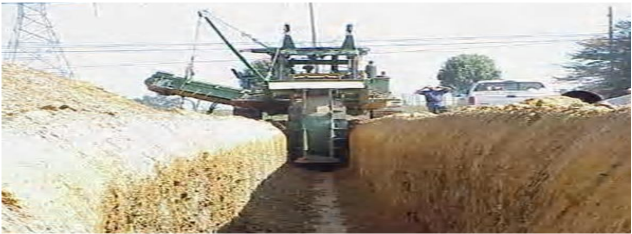
الشكل رقم (٧١) يوضح خط أنابيب التخندق
