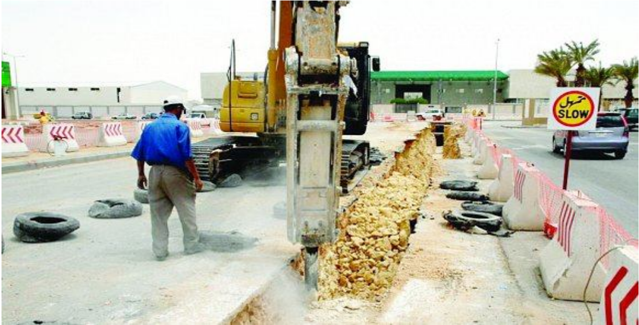
الشكل رقم (٨١) يوضح كيفية تنفيذ حفر الخندق
