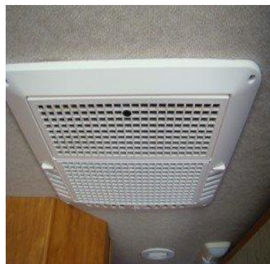
فتحه دخول هواء التكييف المركزي
