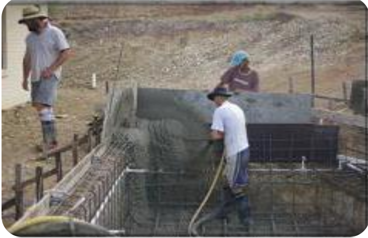
صورة اثناء صب الخرسانه
