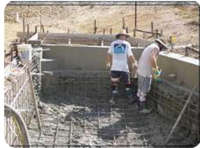
صورة اثناء عمل الحوائط الجانبية
