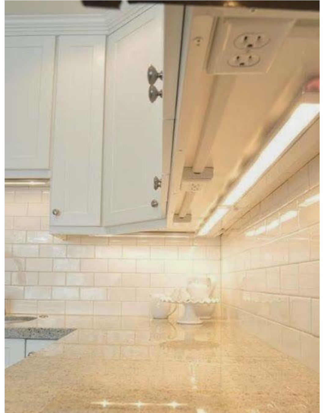
تقنيات الإضاءة غير المباشرة ومخارج الكهرباء الخفية
