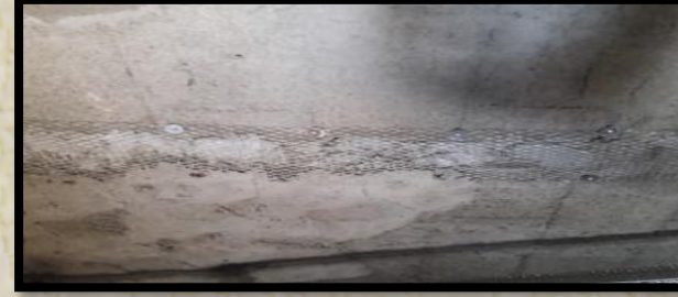
استخدام السلك لتغطية أسلاك الكهرباء
