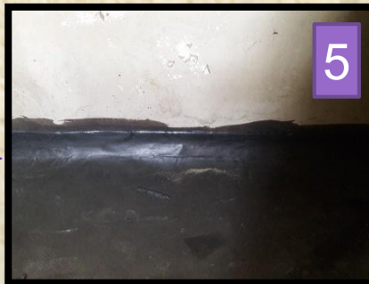
5- عمل رقبة الزجاجه من العزل لحماية السقف الخرسانى
