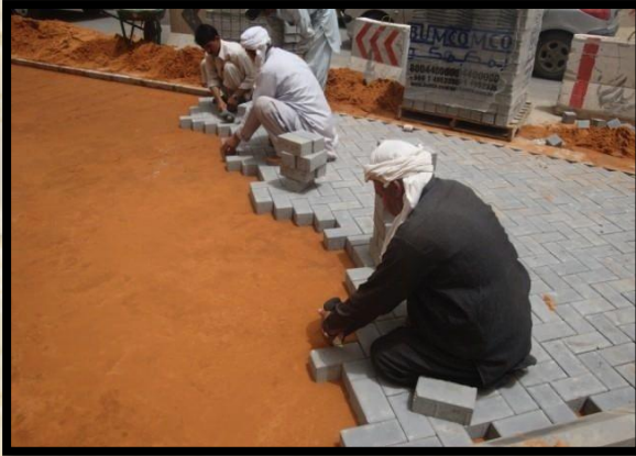
3- يتم تركيب ارضيات الانترلوك
