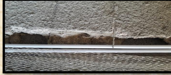
استخدام السلك لتغطية أسلاك الكهرباء
