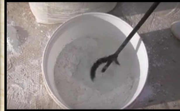
خلط الاسمنت بالماء
