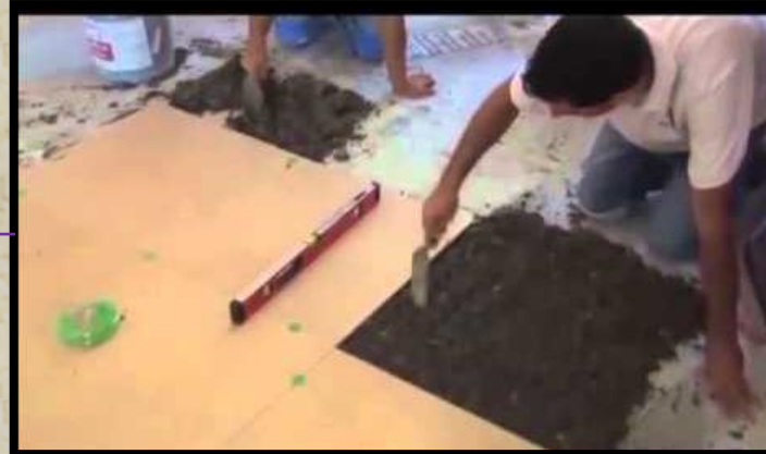
فرد المونه الاسمنتيه اسفل البلاطه بالكامل
