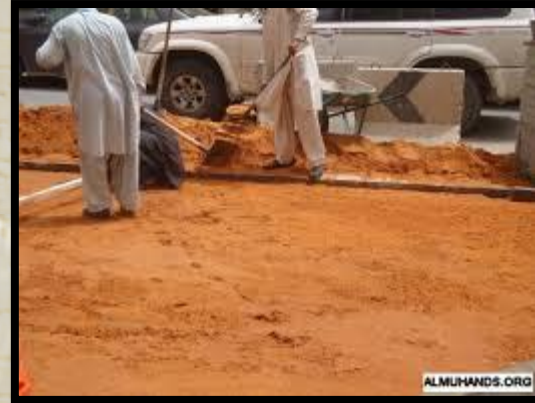
2- يتم غمر الرمال بالمياه وتسويتها
