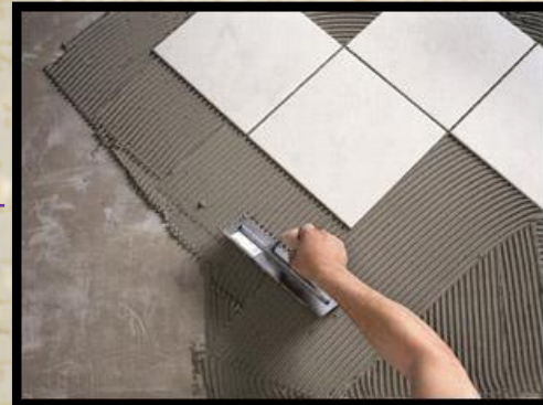
فرد المونه الاسمنتيه اسفل البلاطه بالكامل
