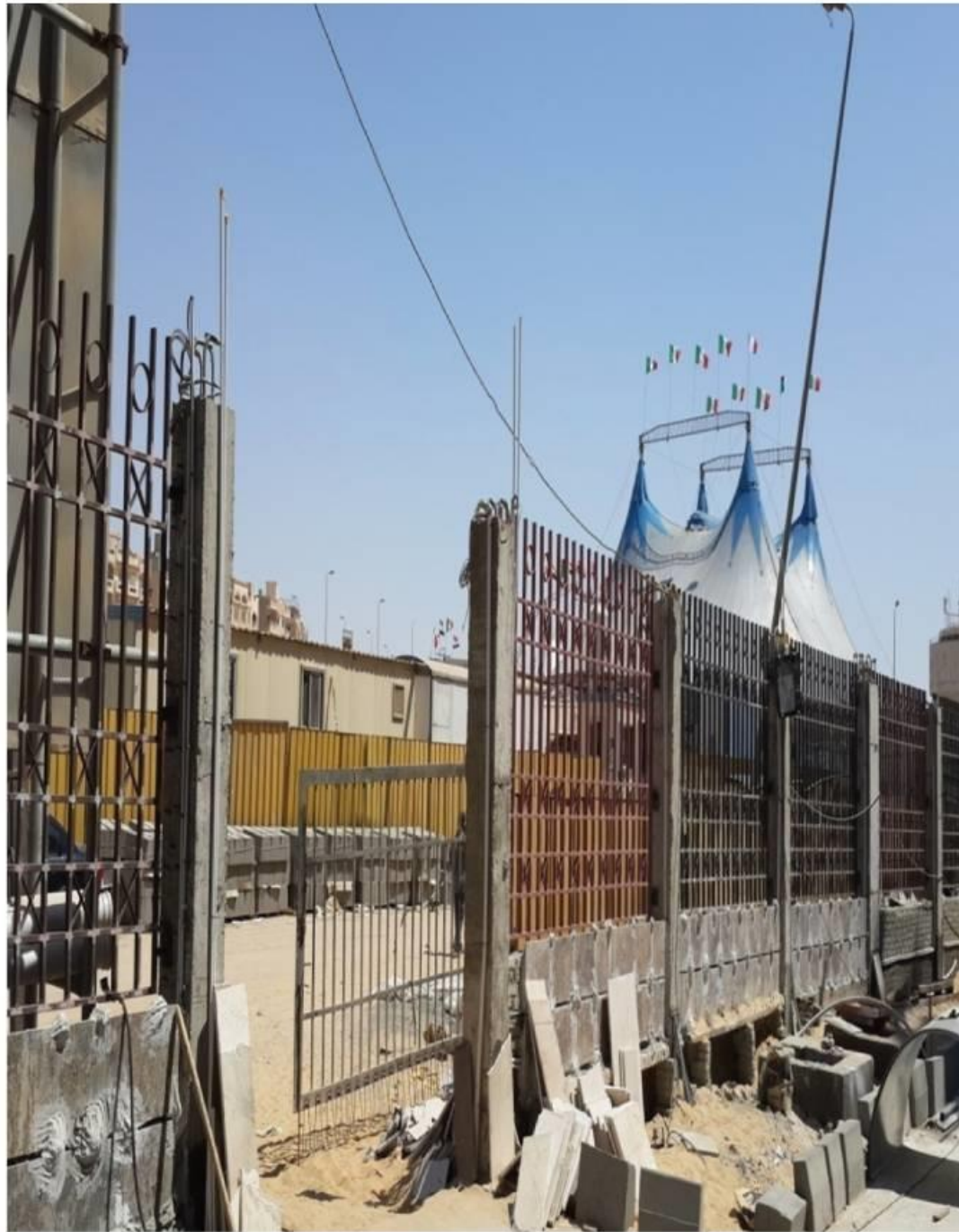
أعمال تركيب السور الحديدي الأمامي وتركيب بردورات الرصيف
