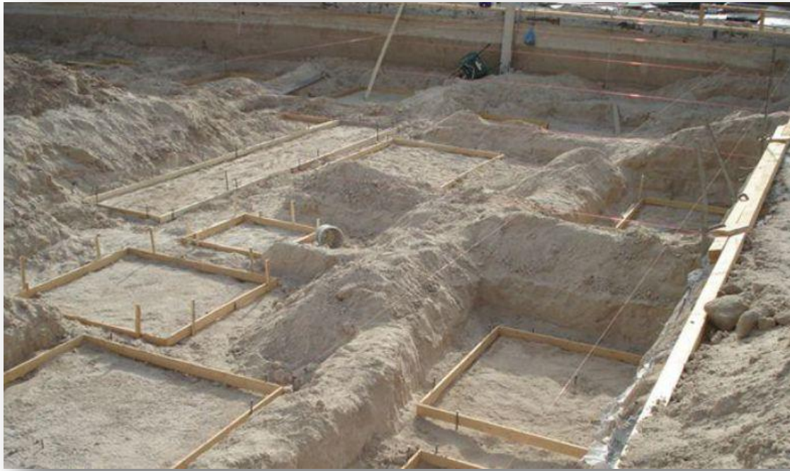
تحديد القواعد وعمل الفورم الخشبي قبل الصب
