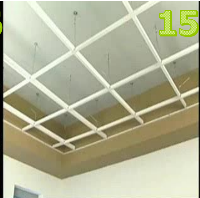
الشكل الأخير بعد تثبيت الزوايا العرضية
