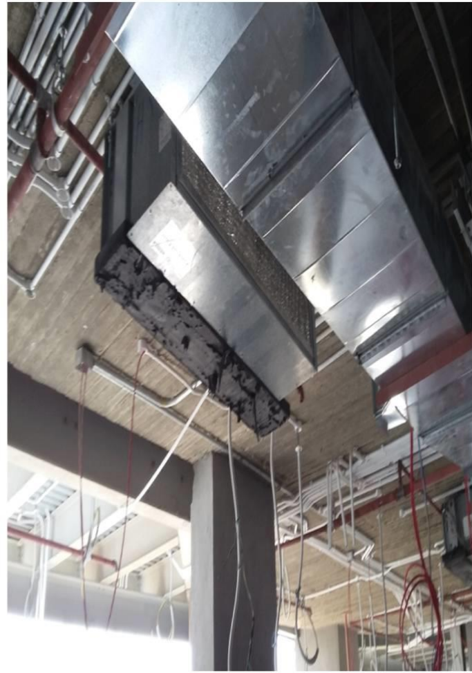
تركيب وحدات ملف التكييف والمروحة
