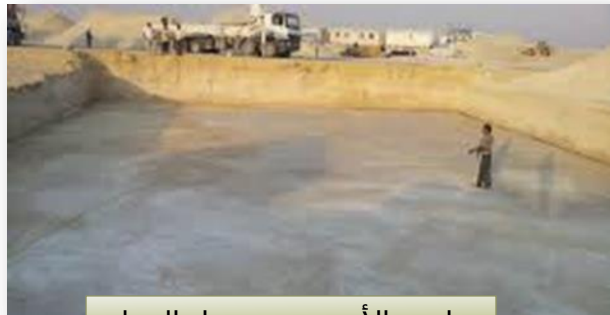
تطهير الأرض وغمرها بالمياه
