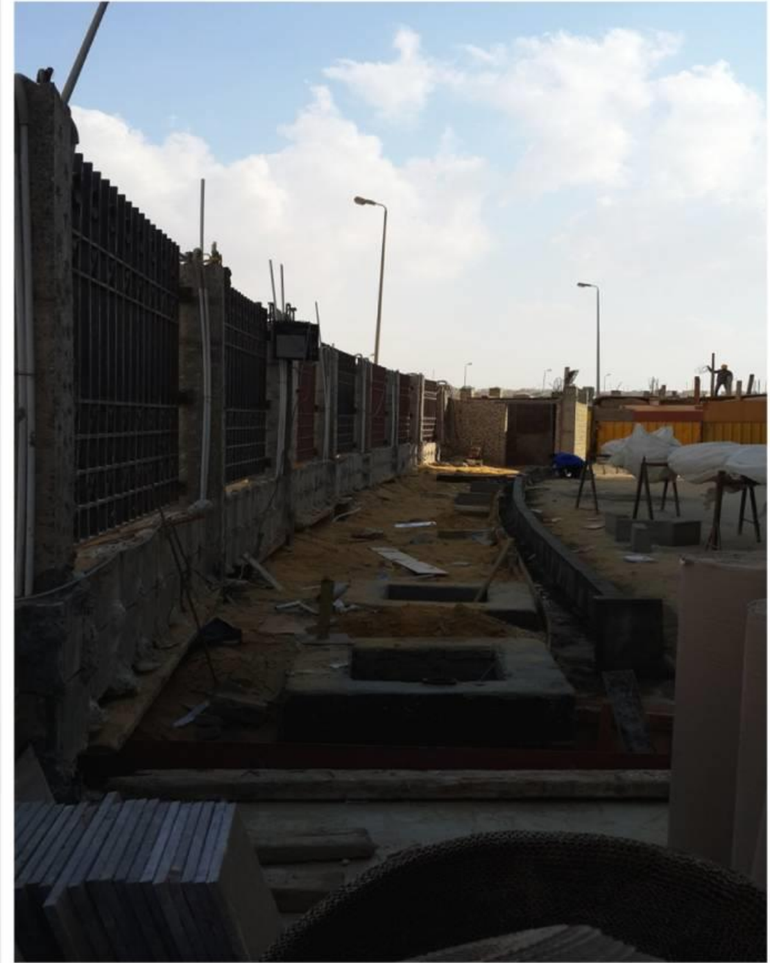
أعمال تركيب السور الحديدي الأمامي وتركيب بردورات الرصيف
