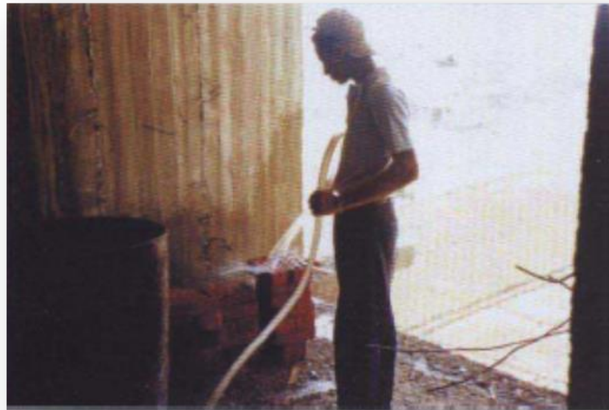
رش الطوب قبل البدء بالبناء
