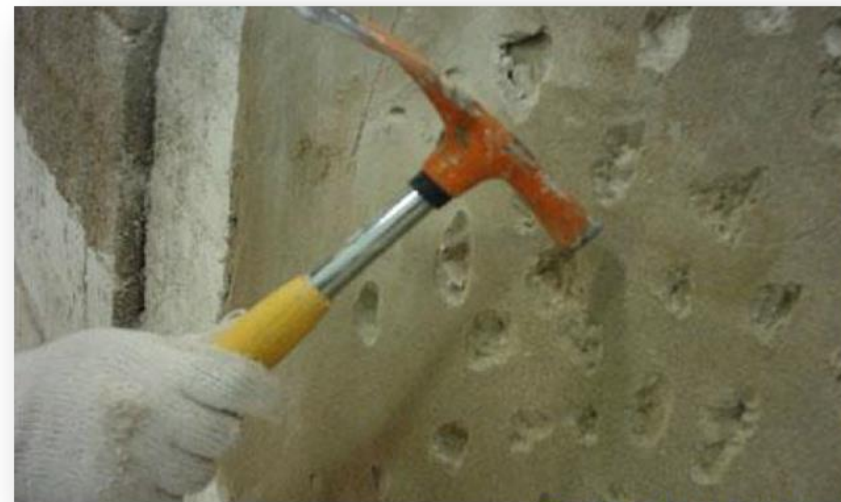
تنقيح سطح الخرسانة الملساء من فورم المعدن
