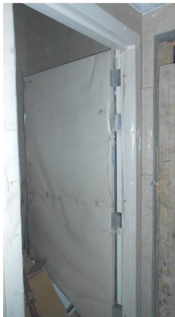
تركيب الأبواب المعدنية الخاصة بالهروب والمقاومة للحريق
