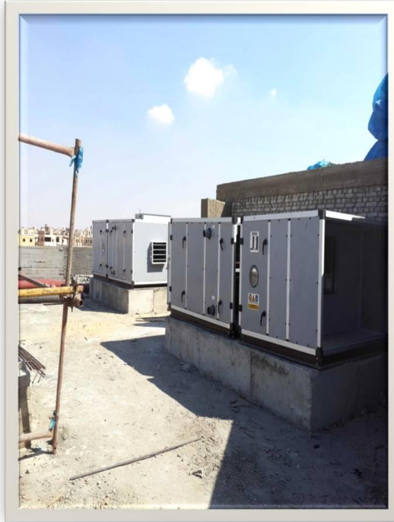
تركيب وحدات مناولة الهواء
