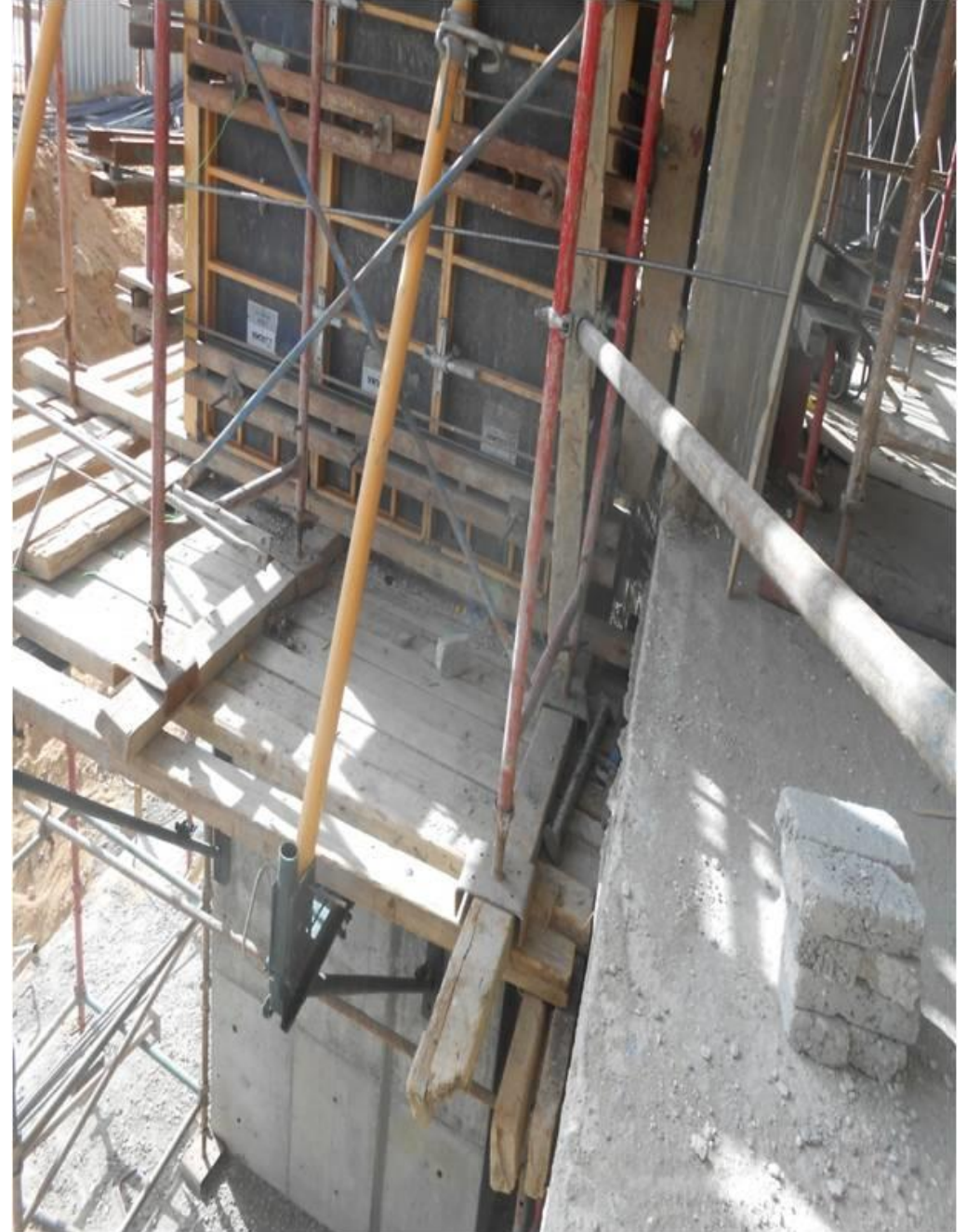
صب جدران المصاعد باستخدام الشدات المنزلقة رأسياً
