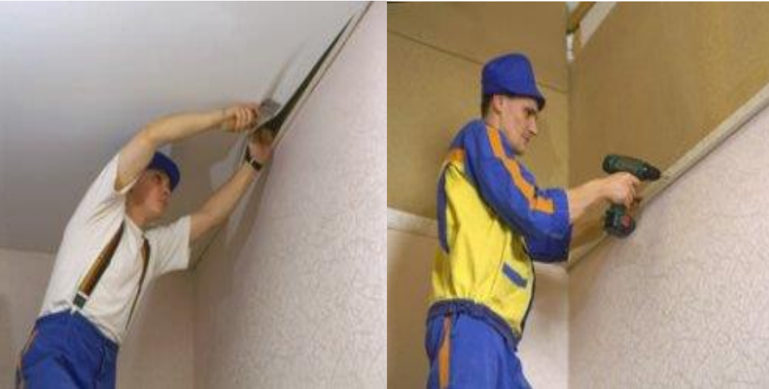
تثبيت الحلية البلاستيكية فى الحائط وتثبيت طرف السقف بها
