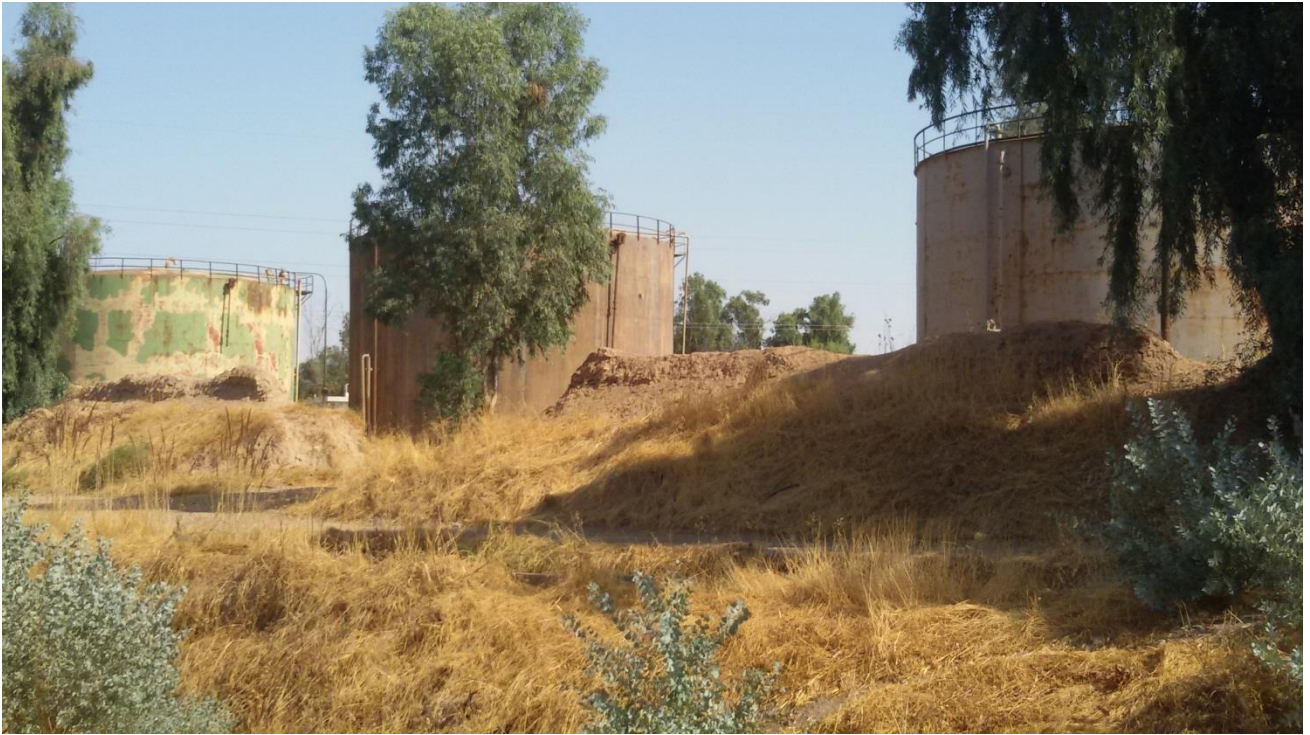
خزانات وقود النفط الخام
