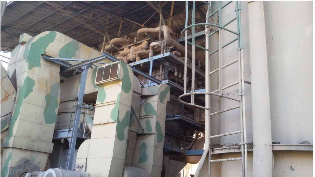
المرجل (الفرن ، مسخنة الهواء ، مجاري الهواء والغازات ، أنابيب وصمامات الماء والبخار)
