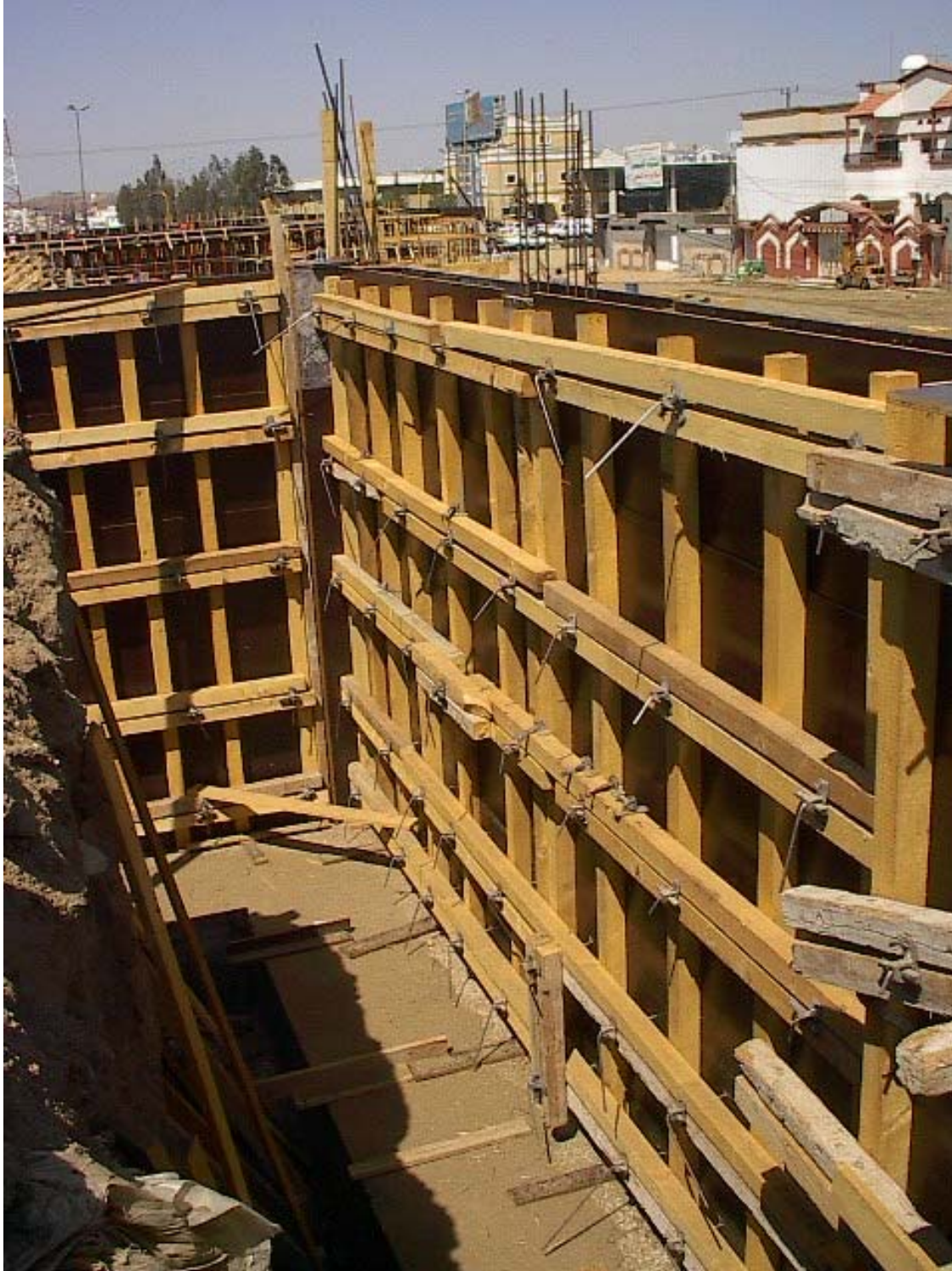
شكل رقم (22) يبين متانة أعمال الشدات الخشبية لحائط خرساني
