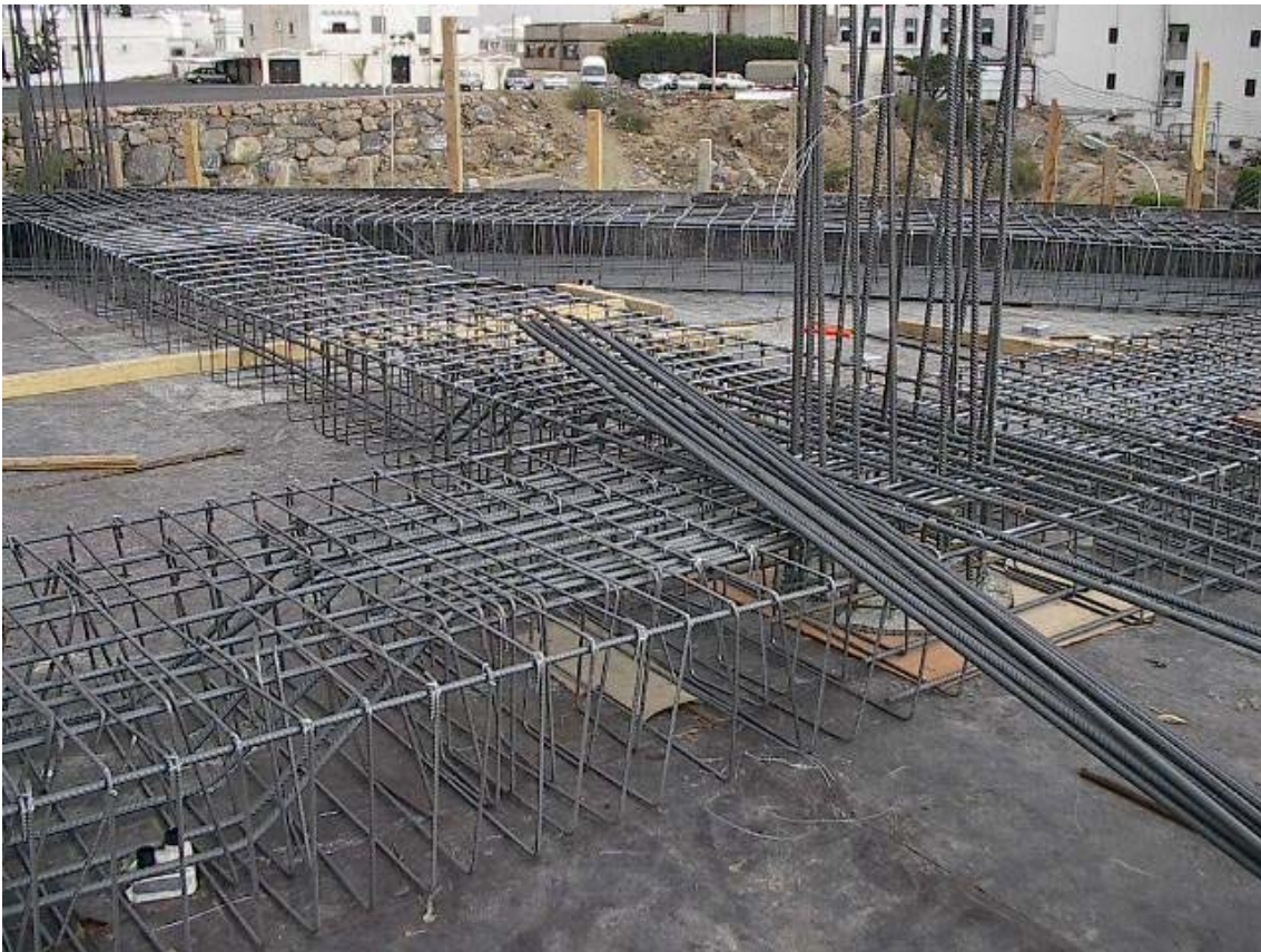
شكل رقم (23) يبين أعمال الحديد لسقف من البلاطات المفرغة
