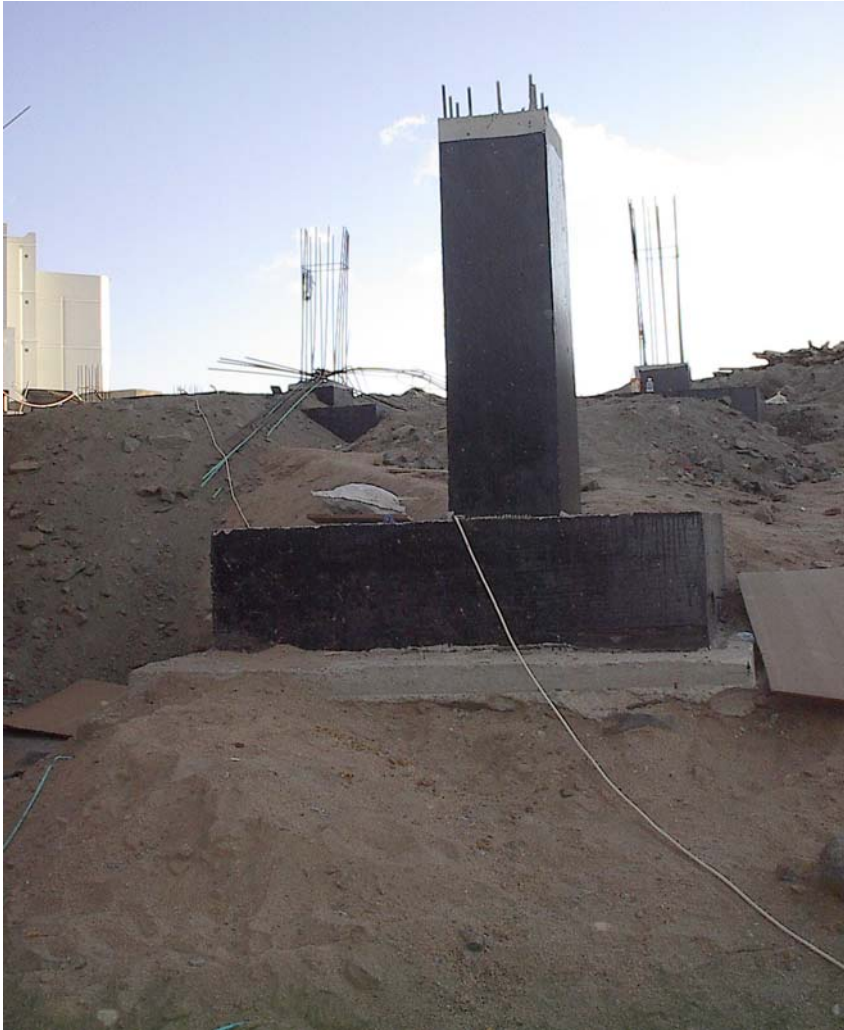
شكل رقم (39) أعمال عزل القواعد ورقاب الأعمدة بالبيتومين المؤكسد الساخن
