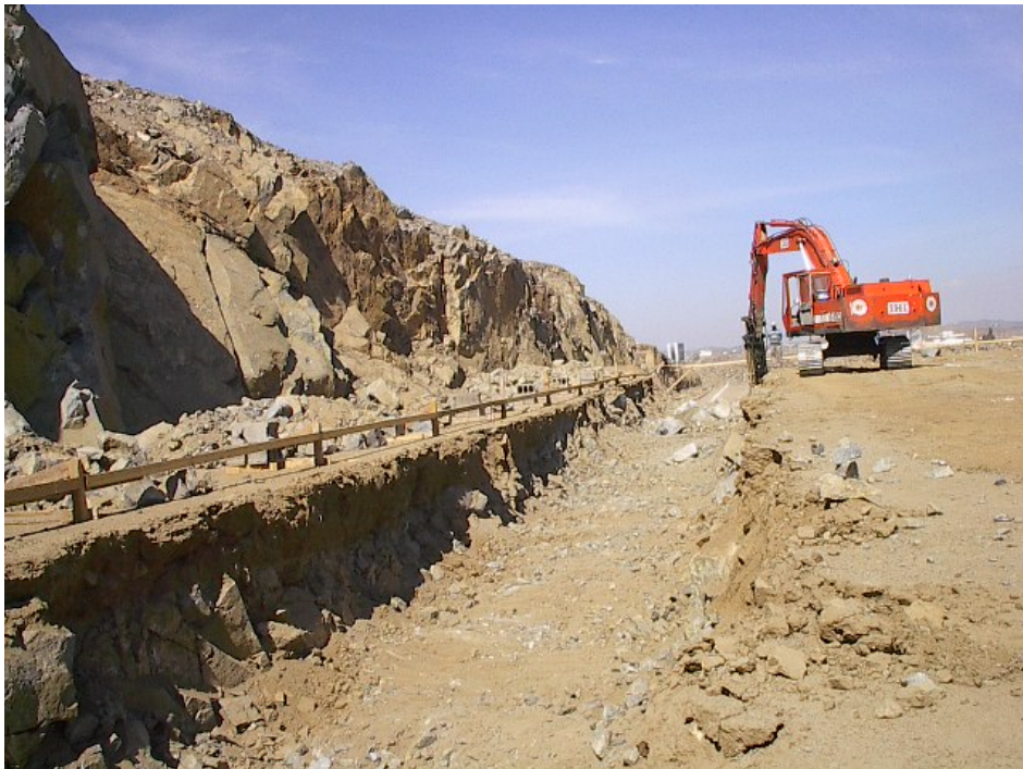
شكل رقم (9) الحفر في تربة صخرية سهلة التفكك
