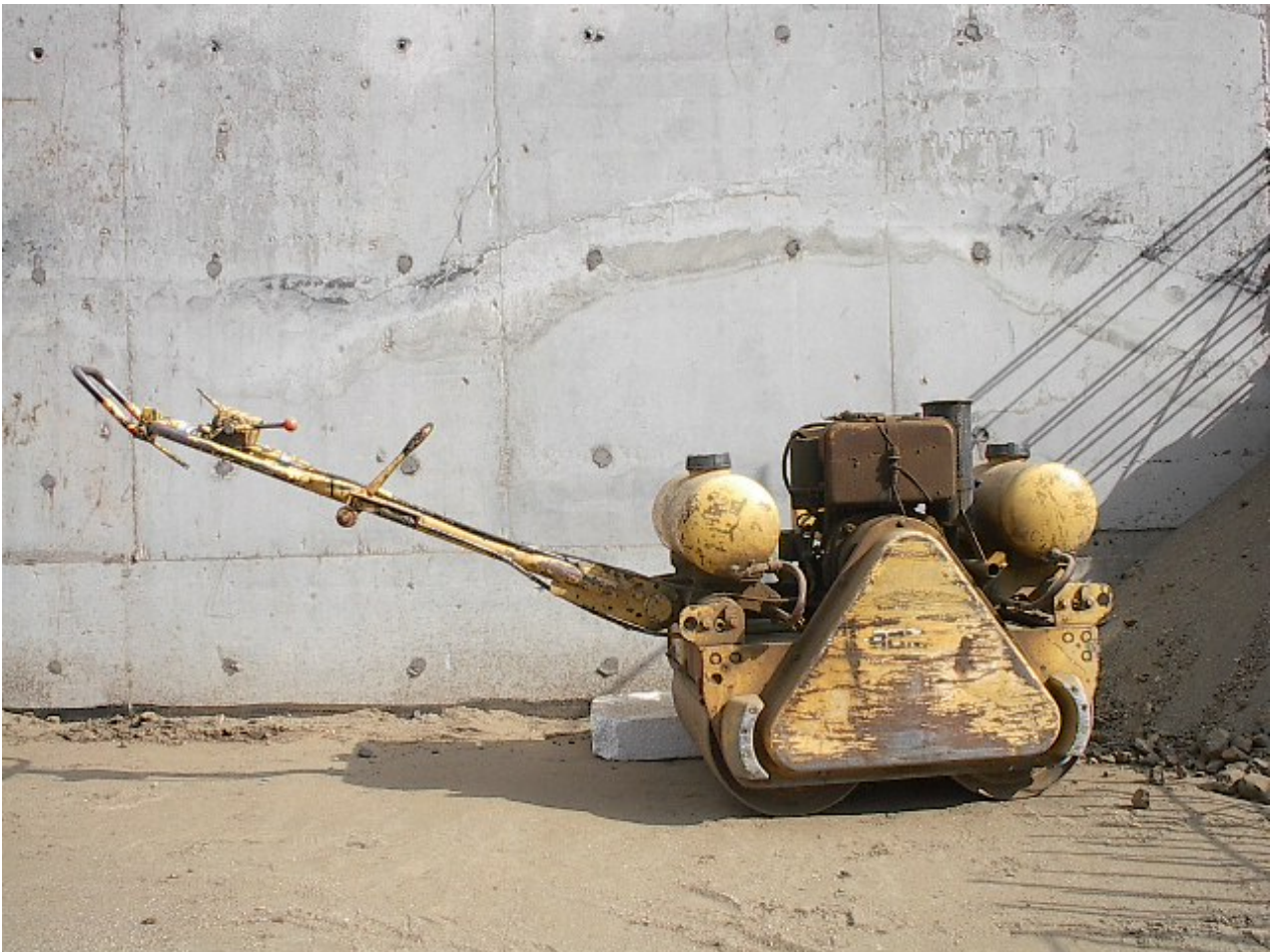
شكل رقم (12) أعمال دك التربة داخل أحد المباني
