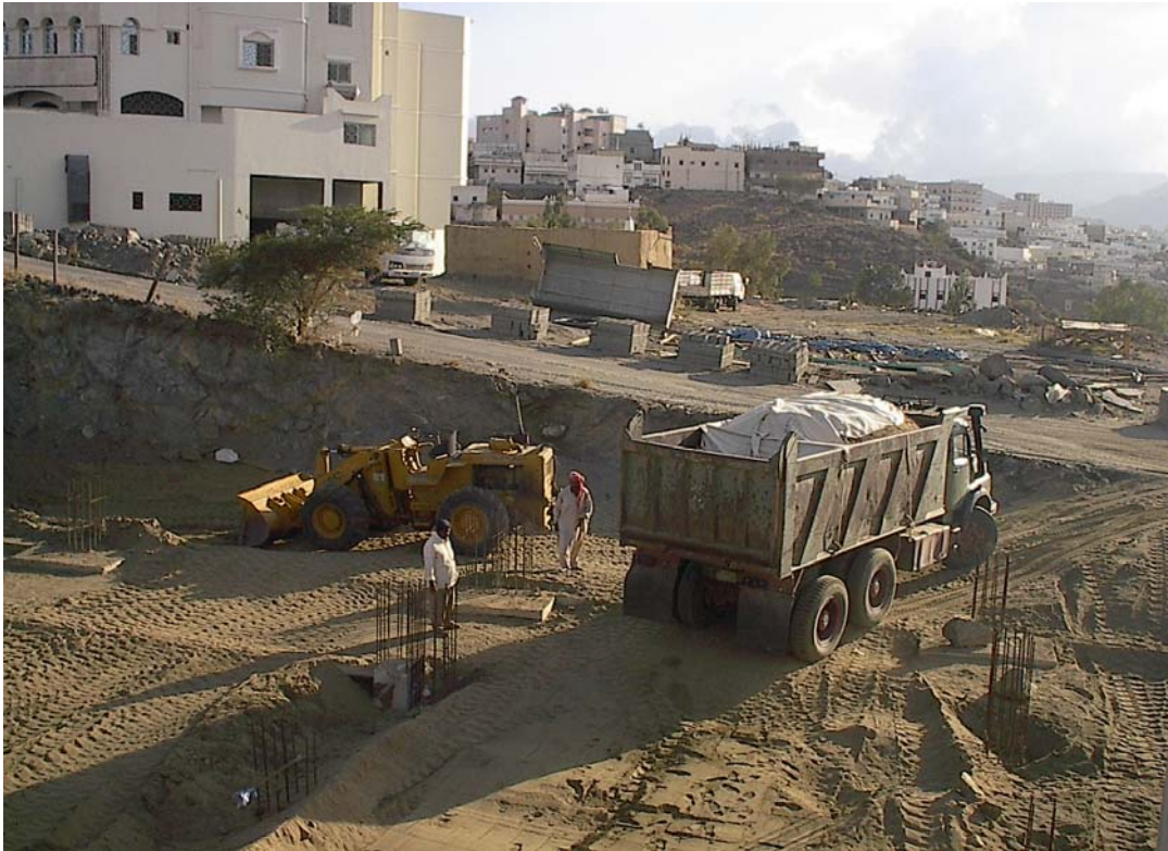
شكل رقم (8) أعمال الحفر والردم في أحد المشروعات
