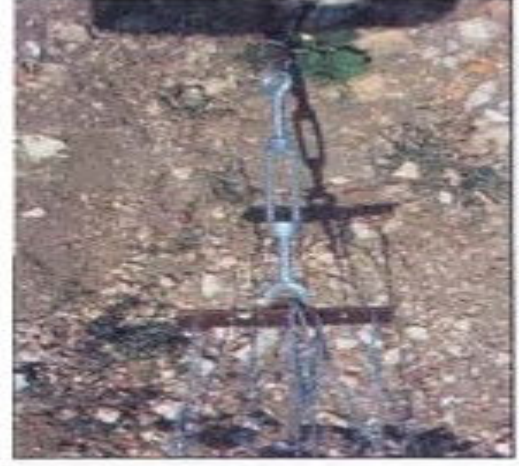
الطريقة الحديثة لتشد أسلاك الـ Pergoletta
