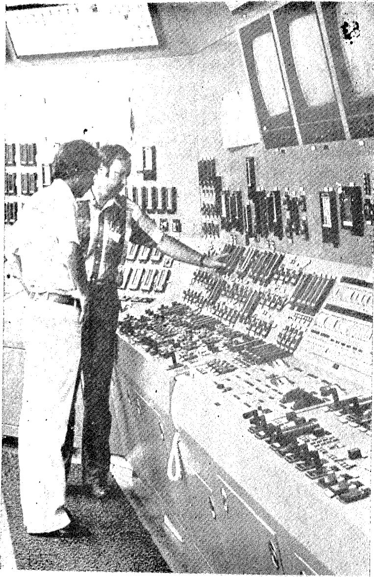
جهاز لحاسبة غرفة المراقبة لمحطة كهرباء، نووية ويستخدم ثلاثة اجهزة كمبيوتر .
