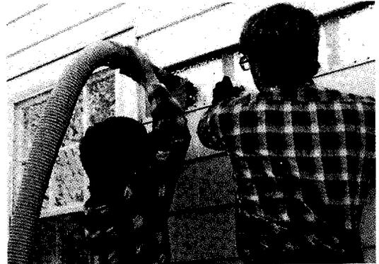
البلاستيك الخثولي يستعمل لعمل سوائيل عزل رغوية وألواح عازلة صلبة. تحقن الرغوة البلاستيكية داخل الحوائط المجهزة خلال ثقوب صغيرة.
