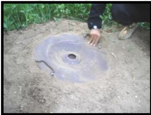
وضعية القاعدة وتثبيتها حيث يجب ملء الفراغات أسفل القاعدة بالحصى والتراب ، وتدبيكها جيداً.
