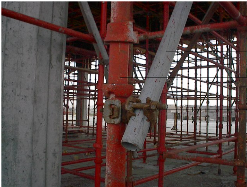
شكل رقم (٩٣) يبين وصلات لربط النهايز مع القوائم المعدنية
