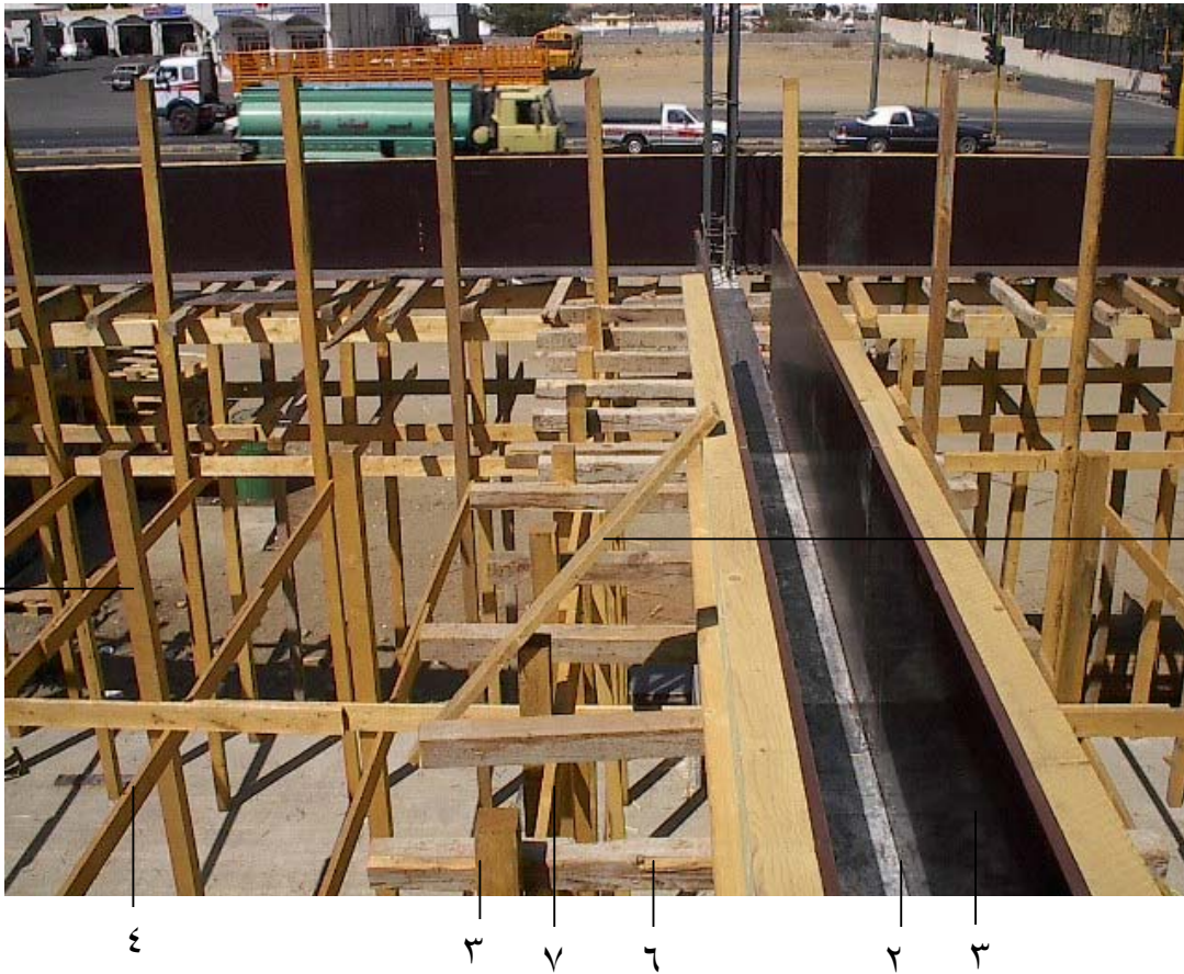
شكل رقم ( ٤٢ ) أعمال التخشب للكمرات
