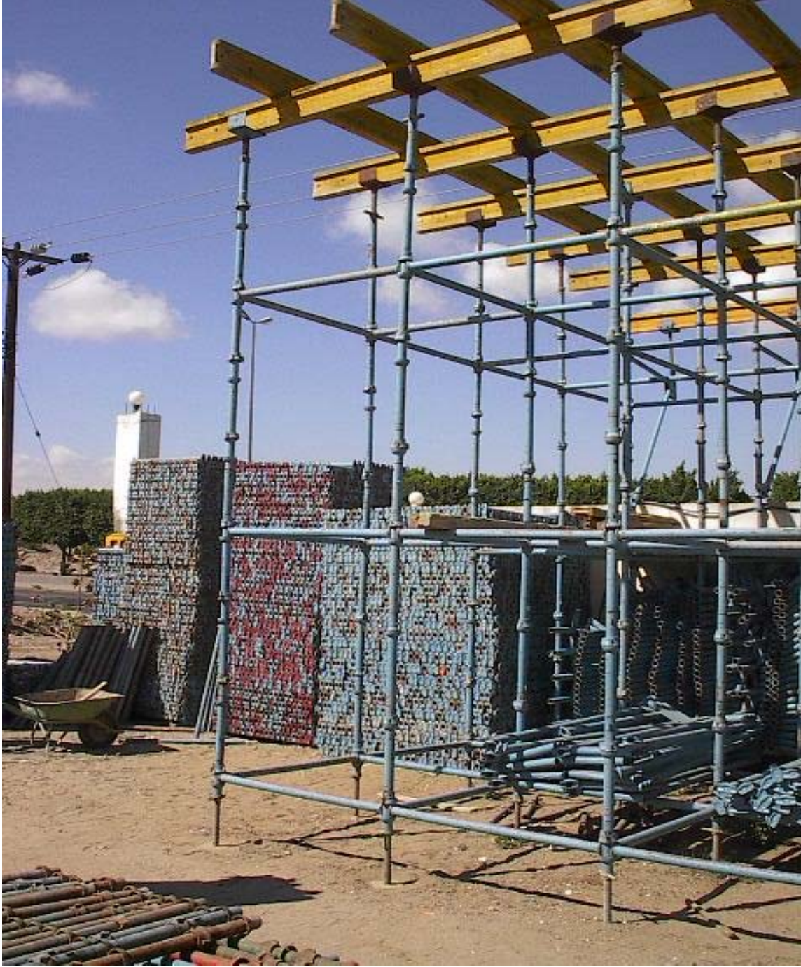
شكل رقم (٨٠) أعمال الشدة المعدنية بنظام الكابلوك
