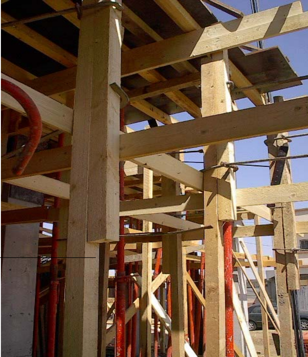
شكل رقم ( ٣١ ) استخدام القمط الحديدية في عمل ضفدعة (وصلات) رأسية لقوائم الأعمدة ١ - قمط حديدية ٢ - عروق ثم عمل وصلات رأسية لها (ضفدعة)
