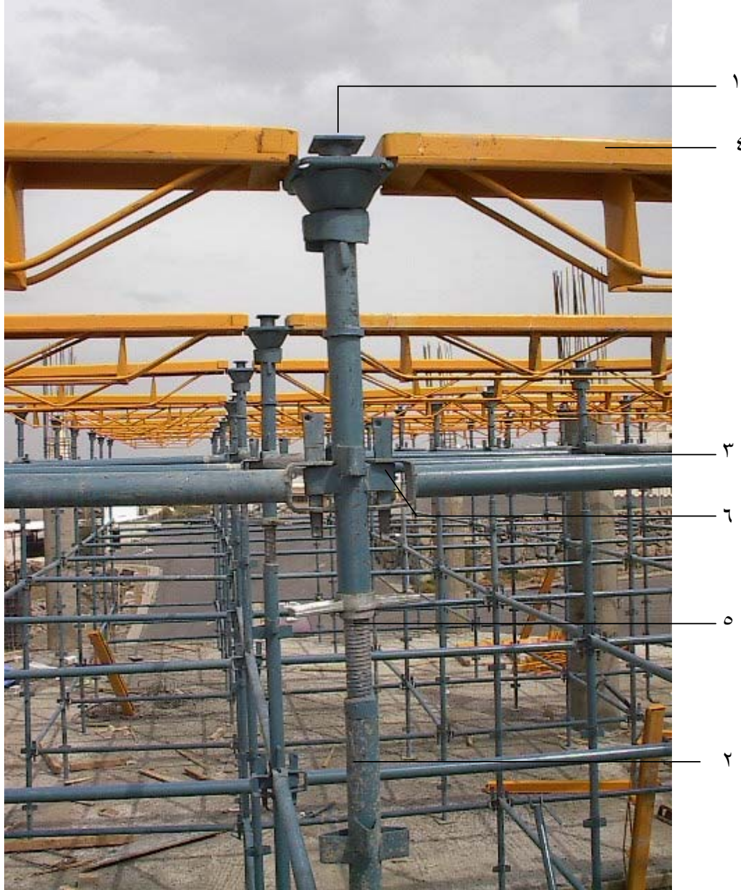
شكل رقم (٩٧) يبين مكونات الشدة المعدنية بنظام الفك السريع
