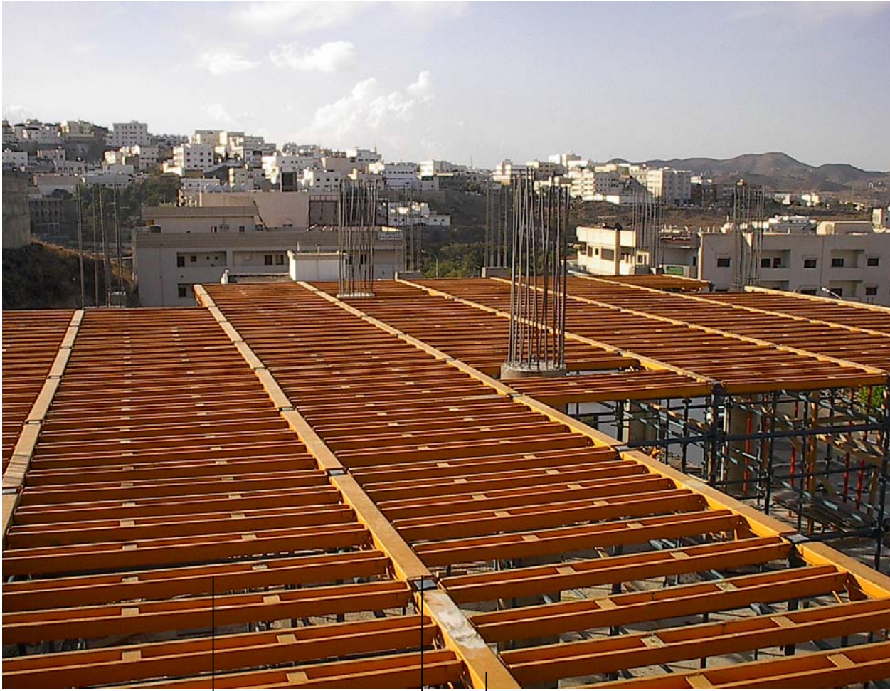
شكل رقم (١٠٣) يبين استكمال تركيب أجزاء الشدة المعدنية للسقف
