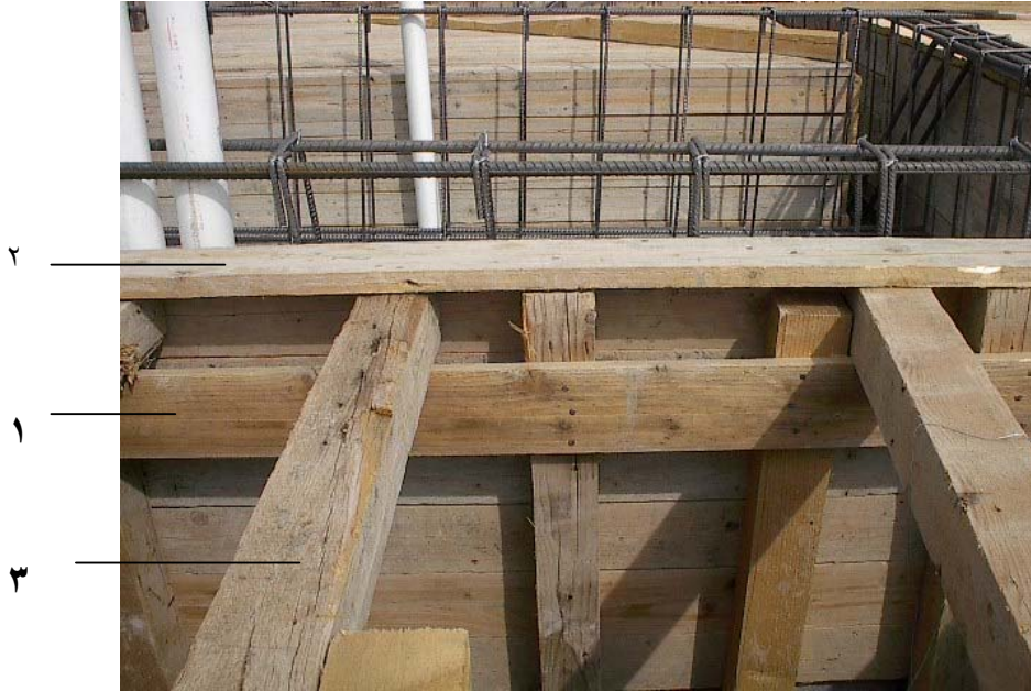
شكل رقم ( ٣٦ ) يبين لوح الزنق في جنب الكمرة
