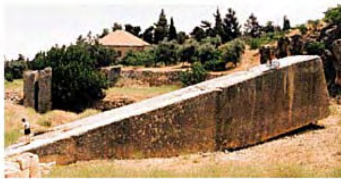
أحد حجارة البناء العملاقة في بعلبك لبنان (يبلغ وزنها حوالي ١٠٠٠ طن!). إنه يمثّل معجزة حقيقية في مجال البناء.
