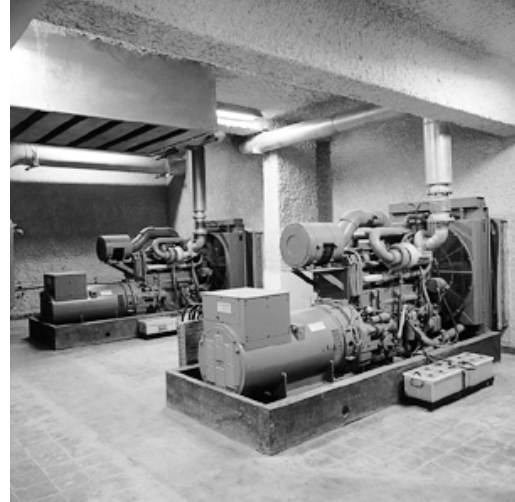
الشكل و ٢٠: أمثلة لمصادر القدرة الاحتياطية: تخزين بطاريات مركزي (يسار) ومجموعة مولدات ديزل (يمين)
