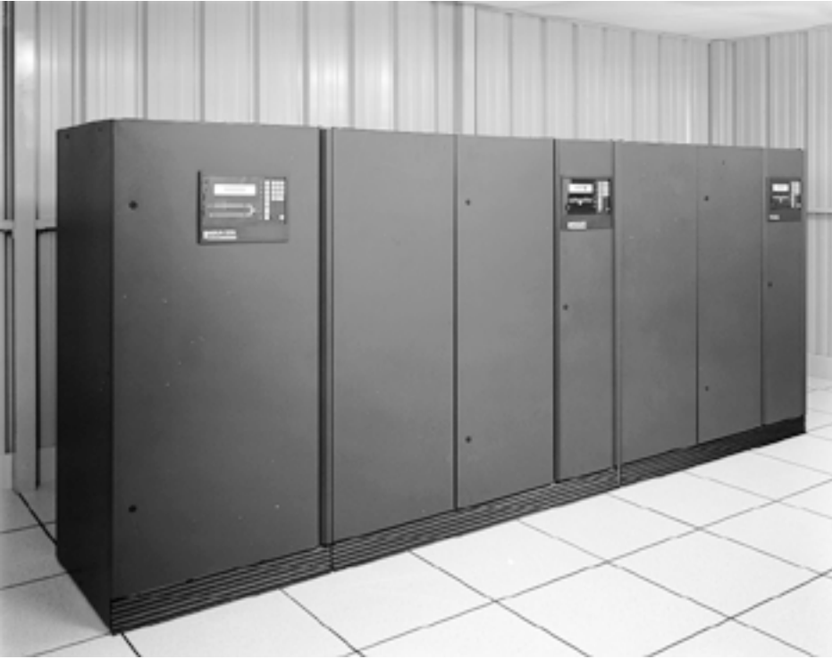
الشكل ي ٢-٢٧: تركيب وحدات التغذية بالقدرة غير القابلة للانقطاع مع أنظمة اتصال ملحقة بها.
