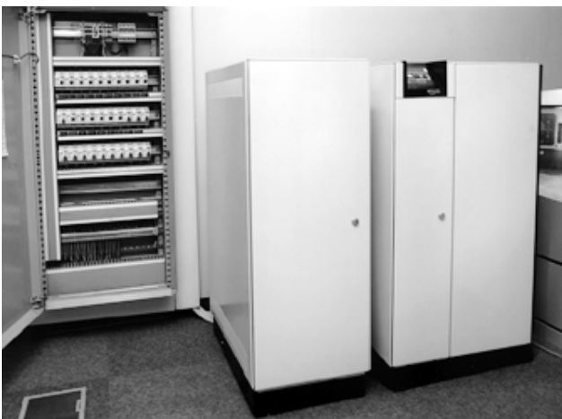
شكل ي ٢-١٤ : توضع نظم ( UPS الكبيرة في غرفة خدمات كهربائية .
