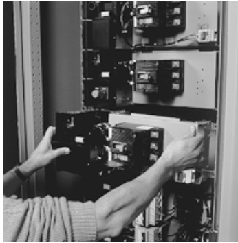
شكل و ٥٥ : لوحات بسمات فصل وقطع على كل وحدة وظيفية
