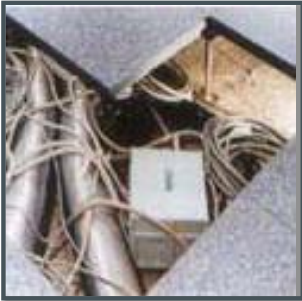
صورة توضح تمرير مواسير التكييف أسفل الأرضية بسهولة
