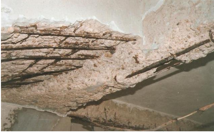
صدأ الحديد يسبب تصدع الخرسانة
