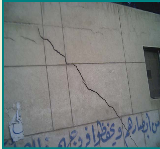
هبوط غير متساوي يؤدي إلى ظهور تشققات أو شروخ بالحوائط
