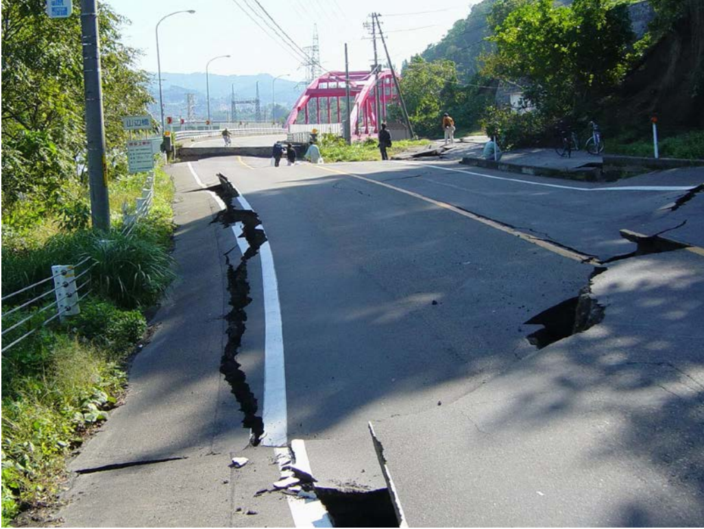
هبوط في التربة نتيجة التفاوت السريع في درجات الحرارة
