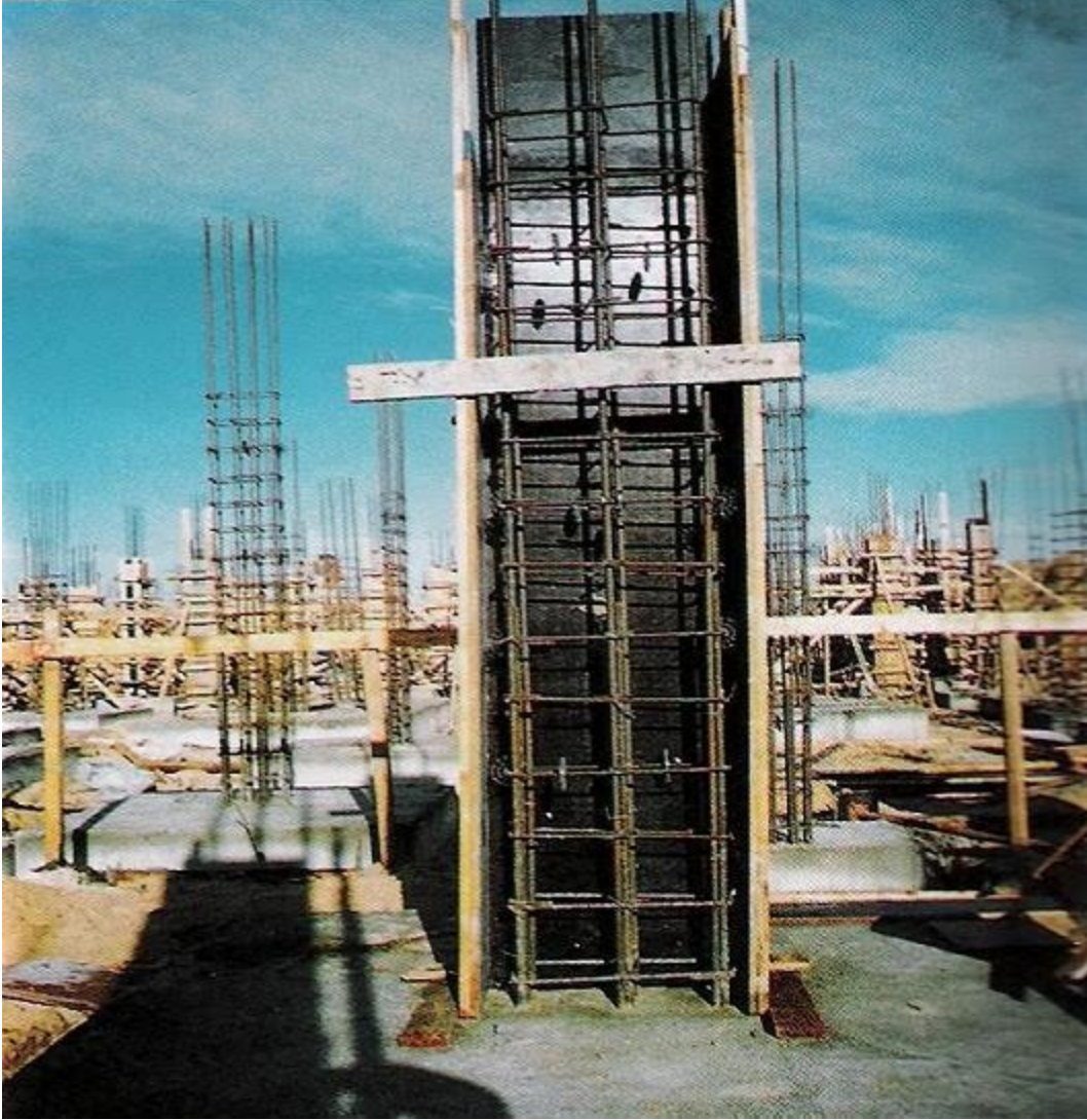
أعمال تسليح عمود تظهر به الكانة الصندوق
