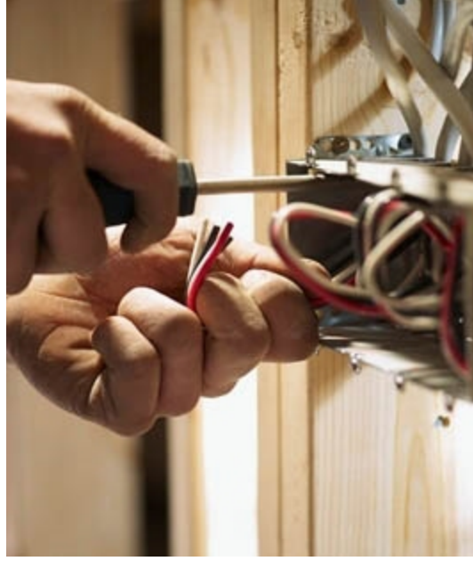
تركيب علب الكهرباء
