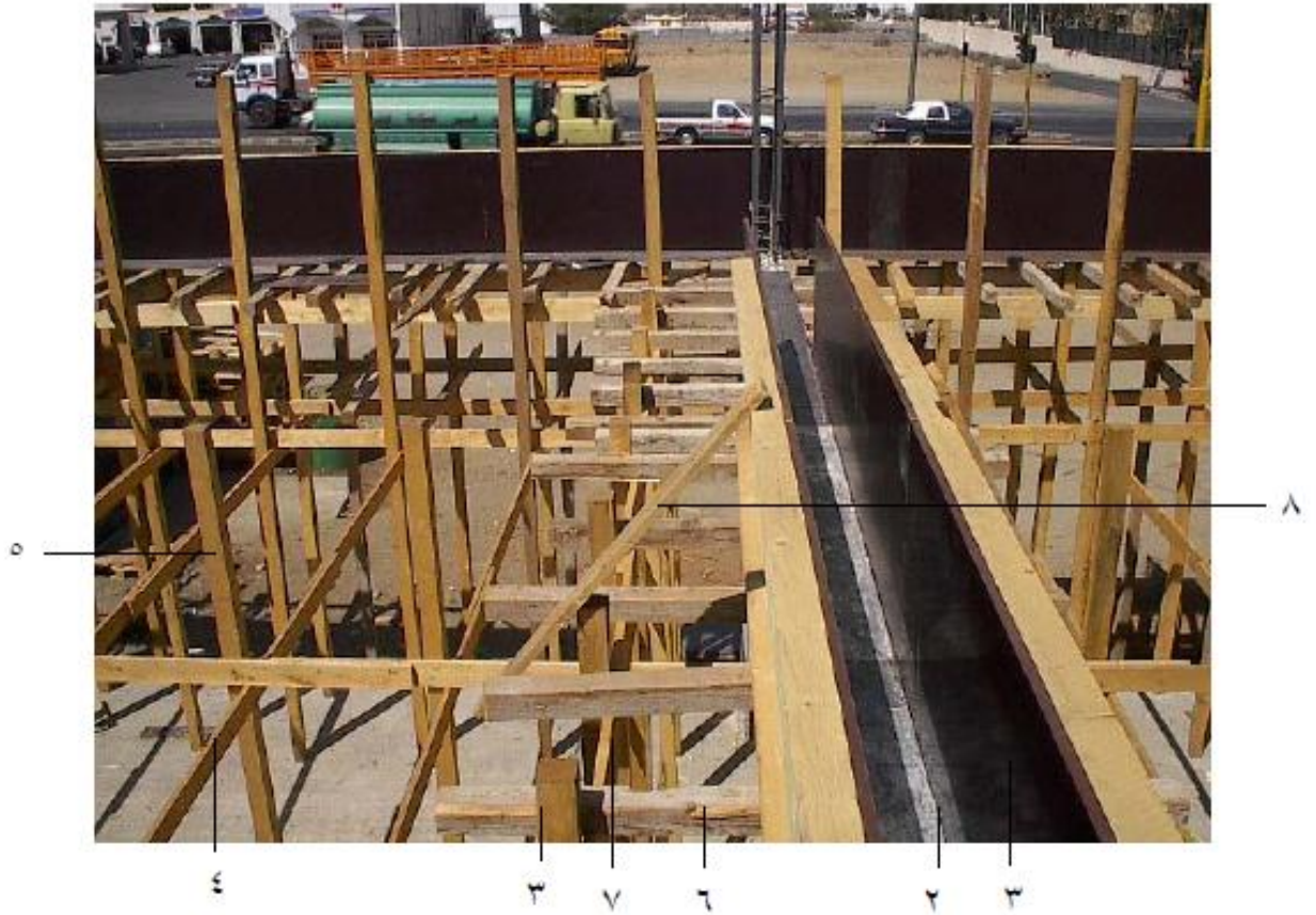
شكل رقم ( ٤٢ ) أعمال التخشب للكمرات
