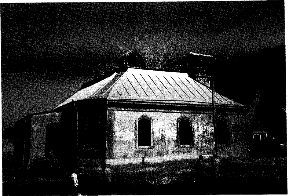
مسجد بلدة كندلن
