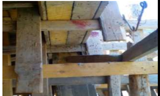
صورة توضح التنوير في السقف وعروق الحبس للكمرات الخارجية
