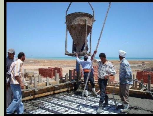
استخدام الهزاز الميكانيكي في الصب
