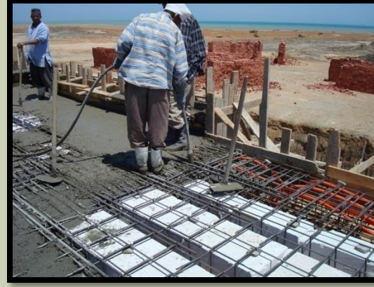
استخدام الهزاز الميكانيكي في الصب
