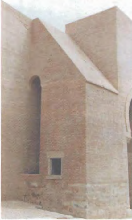
الصورة (٤٩) دعامة بالواجهة الغربية
