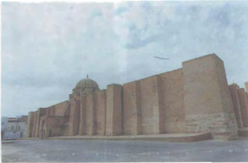
الصورة (٣٩) الواجهة الخارجية الجنوبية
