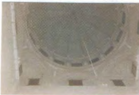
الصورة (٢٨) قبة البهو من الداخل
