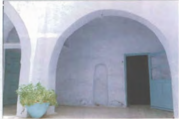
الصورة (١١٣) الرواقان الجنوبي والشرقي بمسجد ابن الصباغ
