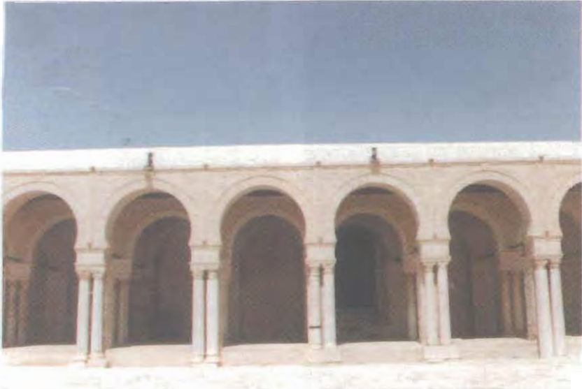
الصورة (٣٣) قسم من واجهة الرواق الشرقي
