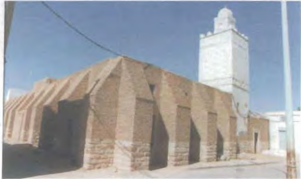
الصورة (٧٢) الواجهة الخارجية الشرقية لجامع الزيتونة
