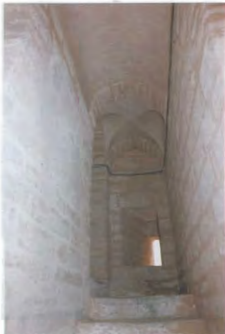
الصورة (٢٢) مرمى سهام في الجدار الغربي من الدور الثاني والسقف القبو المتقاطع
