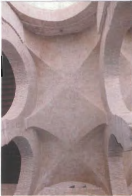
الصورة (٣٠) سقف قبة متقاطع نوع سجدوان
