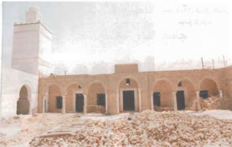
الصورة (٦٦) واجهة الرواق الجنوبي بجامع الزيتونة
