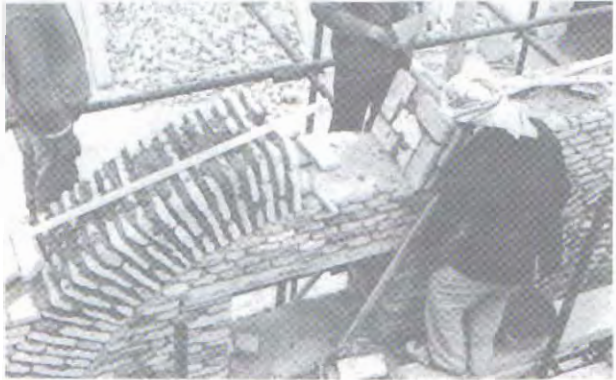
الصورة (٨٨) بناء أفواس الرواق الجنوبي بجامع الباي عام ١٩٨٥
