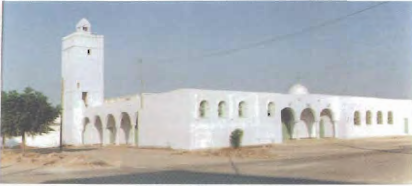
الصورة (١٠١) مئذنة جامع حي المنصورة وواجهاته
