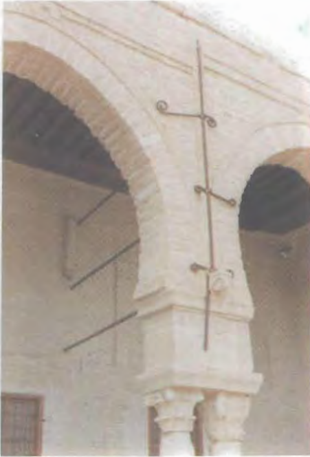
الصورة (٣٤) قطاين الحديد الداعمة لواجهة الرواق الشمالي
