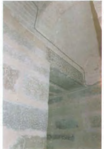
الصورة (٢٠) تجفة ممر المئذنة وسقفه من الداخل
