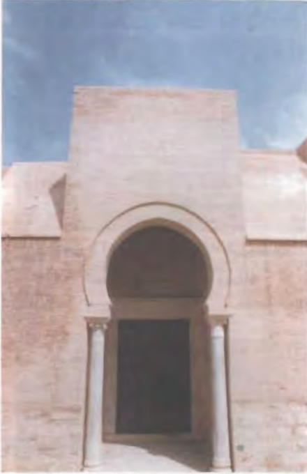
الصورة (٥٣) الباب الثاني بالواجهة الغربية
