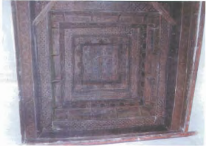
الصورة (١١٧) سقف غرفة الضريح بمسجد الداروني
