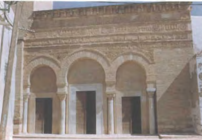
للصورة (١٤٨) واجهة مسجد الأبواب الثلاثة بعد الترميم (عام ١٩٩٢)
