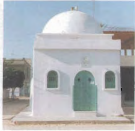
الصورة (١٢٢) الواجهة الشرقية بمسجد البرهان
