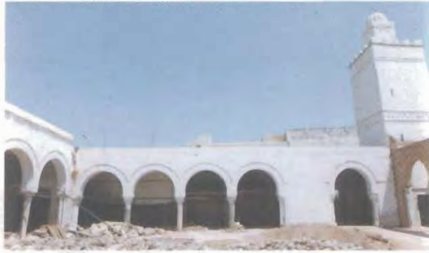
الصورة (٦٩) الرواق الشرقي بجامع الزيتونة
