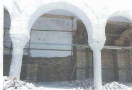
الصورة (٧٠) بناء دعامات وأقواس داخل الرواق الشرقي بجامع الزيتونة
