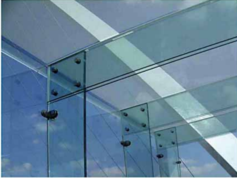
(الشكل 27.7) تفاصيل الزجاج البنيوي - سرادق عند جسر غيتسهيد الألفي؛ المعمار يون ويلكنسون إير .
