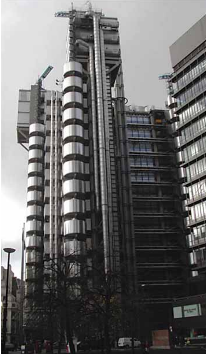
(الشكل 17.5) أعمال التشييد بالفولاذ المقاوم للصدأ مبنى لويدز في لندن. المعمارين: روجرز ستارك هاربر (Rogers Stirk Harbour) وشركاه. صورة: آرثر ليونز (Arthur Lyons).
