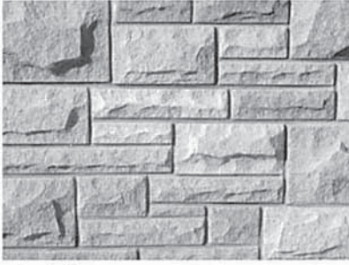
بناء الجدران بالحجر المنشور المترصف عشوائياً والمشطوف بالميل
