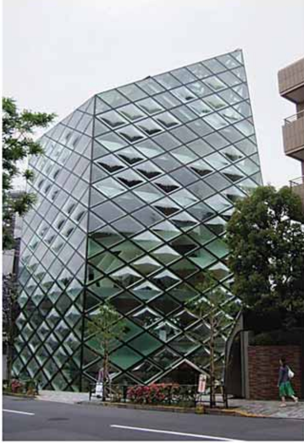
(الشكل 14.7) ألواح زجاج معينية محدة - مخزن برادا، طوكيو.
