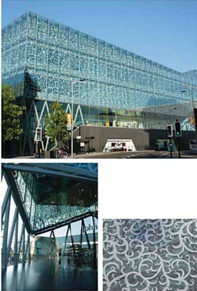
(الشكل 8.7) واجهة من الزجاج المطبوع شبكياً - مخزن جون لويس، لايسستر.
