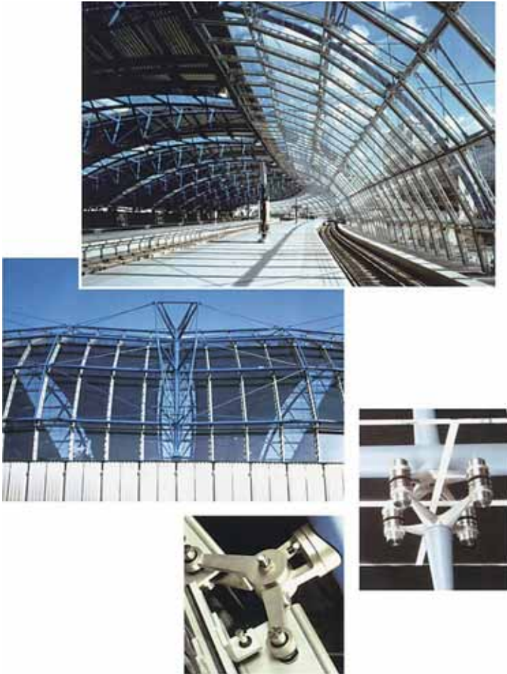
(الشكل 1.5) أشغال الفولاذ الهيكلي - محطة واترلو (Waterloo) للقطارات، لندن. المهندسون المعماريون: مهندسون معماريون غريمشو (Grimshaw). الصور: بالإذن من (Jo Reid & John Peck, Peter Strobel).
