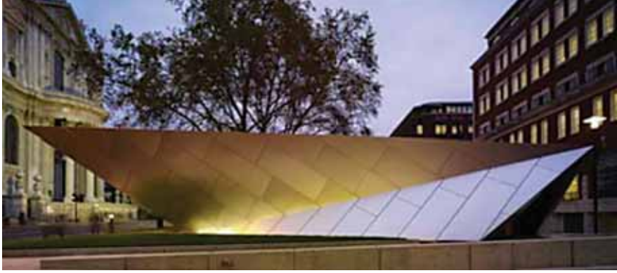
(الشكل 18.5) أعمال التشييد بالفولاذ المقاوم للصدأ لمركز معلومات مدينة لندن - سانت بول (St Paul's) . المعمارين : (Make Architects.) . صورة : (Zander Olssen) .
