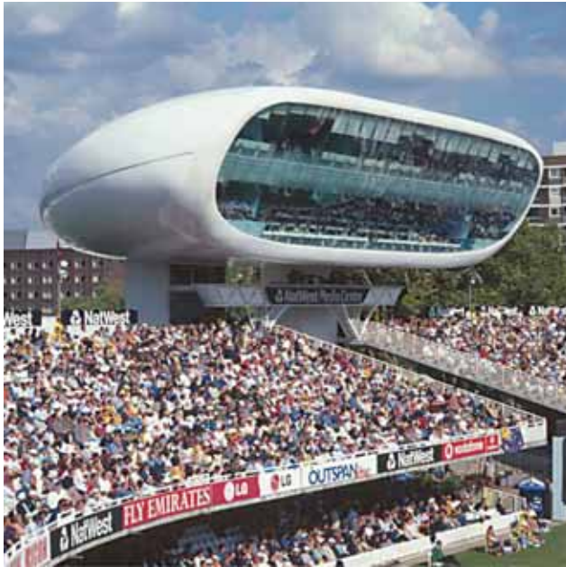
الشكل (21.5) أعمال التشييد نصف المونوكوكي من الألومنيوم - مركز اللورد الإعلامي، لندن. المعمارين: أنظمة المستقبل (Future Systems). الصورة: بإذن من ريتشارد دايفس (Richard Davies).
