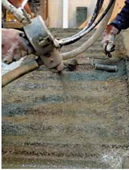
(الشكل 5.11) رش الإسمنت المسلَّح بالألياف الزجاجية. الصورة بإذن (Trent Concrete Ltd.).
