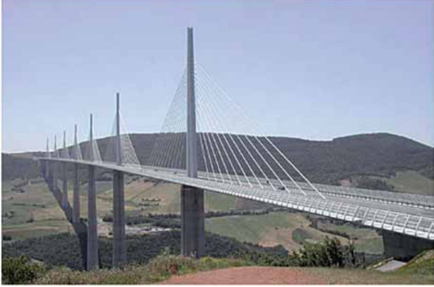
(الشكل 22.3) أعمدة خرسانية - جسر ميللو فوق وادي تارن - فرنسا. المعمارين (Foster + Partners). تصوير (Arthur Lyons).
