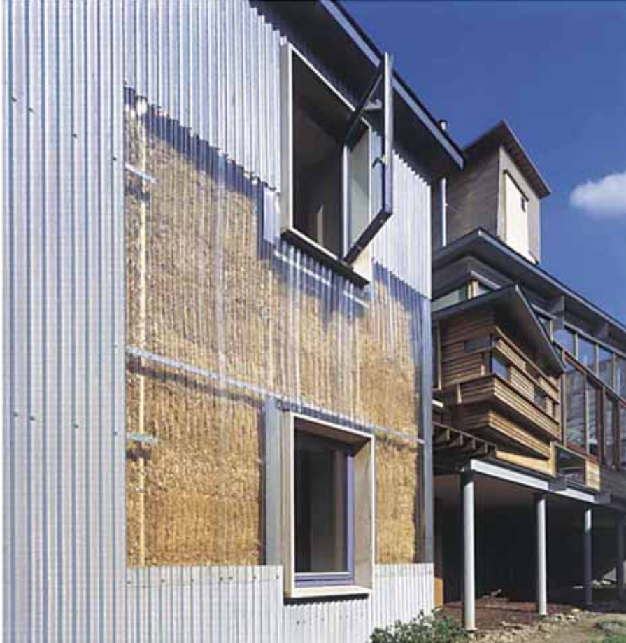
(الشكل 2.17) بالات القش في التشييد. المعمارين والصورة: (Sarah Wigglesworth Architects).
