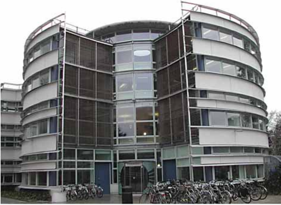
(الشكل 19.5) أجهزة تظليل من الألومنيوم - كلية اللاهوت، جامعة كامبردج. المعمارين: إدوارد كولنن (Edward Cullinan). صورة: آرثر ليونز (Arthur Lyons).
