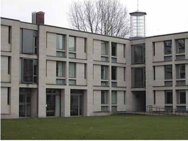
(الشكل 10.9) أحجار بات - قاعة فوندرس كلية بمبروك، كامبردج. المعماريون: إريك باري للعمارة. الصورة: آرثر ليونز.
