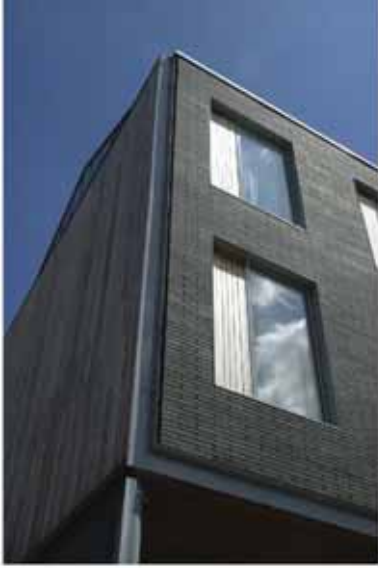
(الشكل 3.1) الأجرّ الخطّي، الصور: بإذن من شركة إيبستوك للأجرّ (Ibstock Brick Ltd.).
