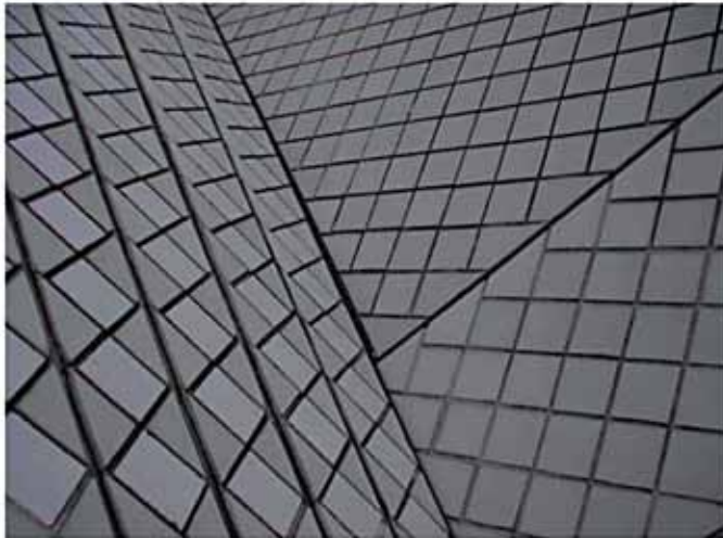
(الشكل 1.8) خزف سقف دار الأوبرا في سيدني وتفصيله، المعماريون: (Jern Utzon and Ove Arup). الصورة: (Arthur Lyons).
