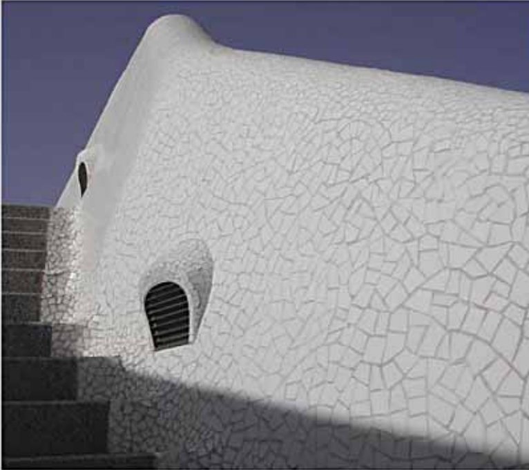
(الشكل 11.8) إنهاء وتفصيل فسيفساء خزفي - قاعة الموسيقى، تنيريف (Tenerife) المعماري (Santiago Calatrava). الصورة آرثر ليونز (Arthur Lyons).
