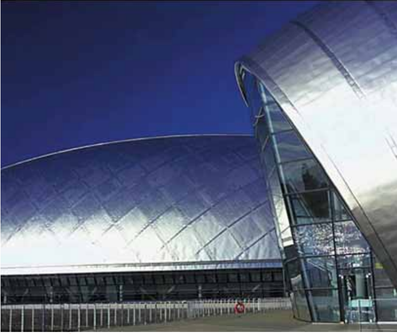
(الشكل 32.5) الكسوة بالتيتانيوم - مركز غلاسكو للعلوم. شركة تصميم الأبنية (Building Design Partnership, BDP). الصورة: بإذن من دون كليمنتس (Don Clements).
