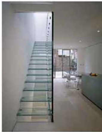
(الشكل 28.7) درج زجاجي - منزل في ناتينغ هل، لندن.
