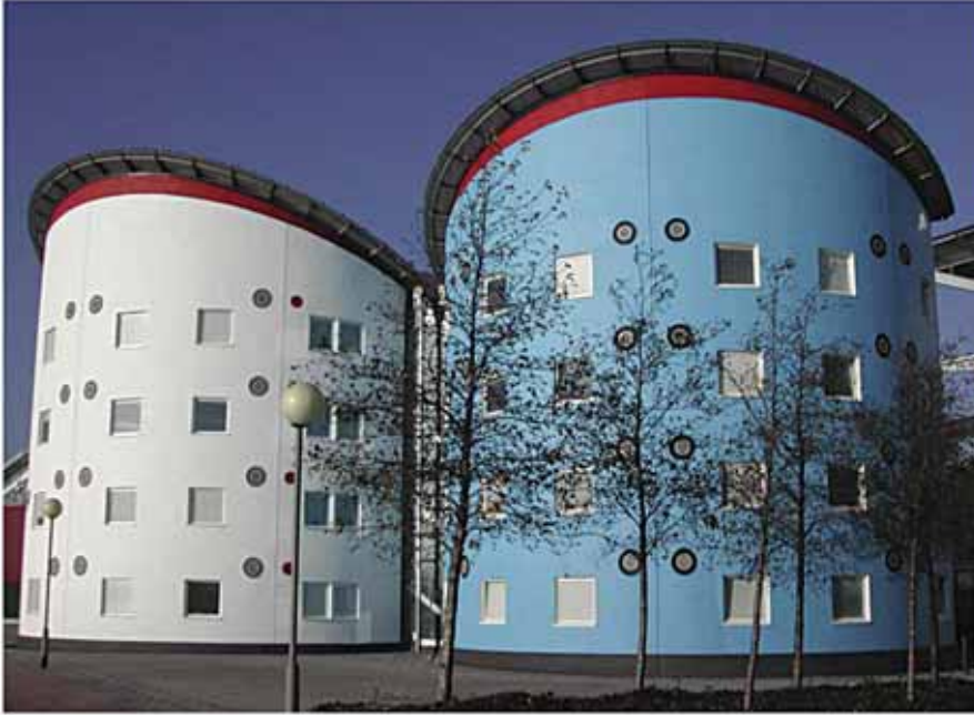
الشكل 26.3 بلوك مغطى بالطين - جامعة شرق لندن - حرم دوكلاندز. المعماريون: (Edward Cullinan Architects). تصوير (Arthur Lyons).
