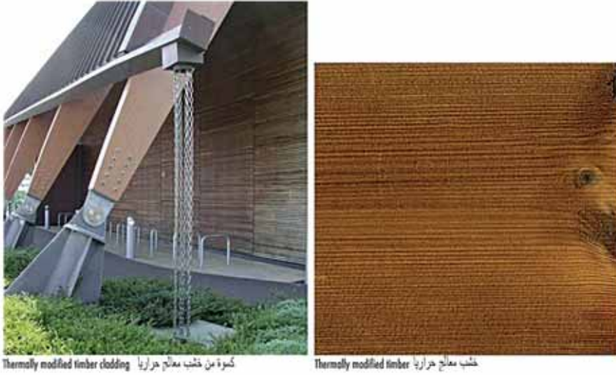
(الشكل 16.4) إكساء بالخشب المعالج حرارياً (Thermally Modified Timber Cladding) - مركز خلية النحل، كامبردج (The Beehive Centre, Cambridge. Photographs: Arthur Lyons).
