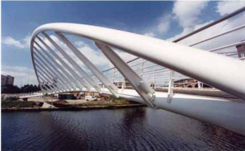
(الشكل 10.5) المقاطع الفولاذية المنحنية. جسر مارشنت. مانشستر (Manchester). الصورة: بإذن من شركة (The Angle Ring Company).
