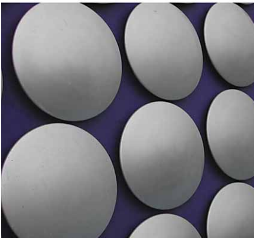
(الشكل 20.5) أقراص الألومنيوم - متجر سيلفريدجز (Selfridges)، برمنغهام، المعماريون: فوستر (Foster) وشركاه. صورة: آرثر ليونز (Arthur Lyons).
