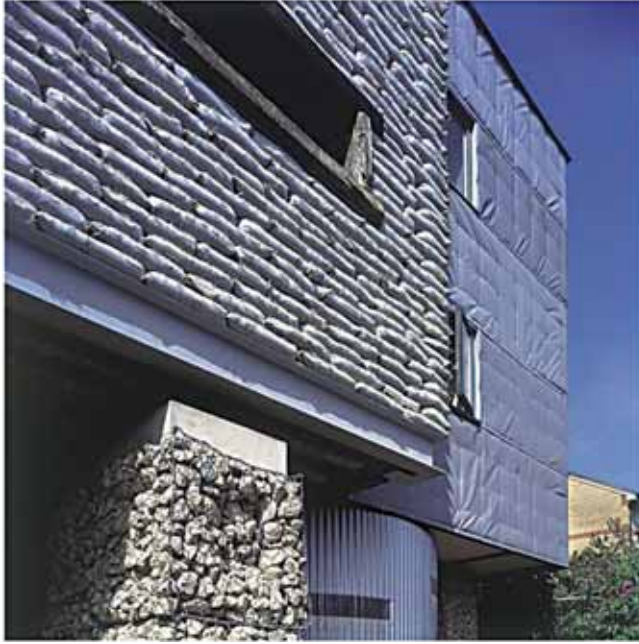
(الشكل 6.17) أكياس الرمل في التشييد. المعمارين والصورة: (Sarah Wigglesworth Architects).
