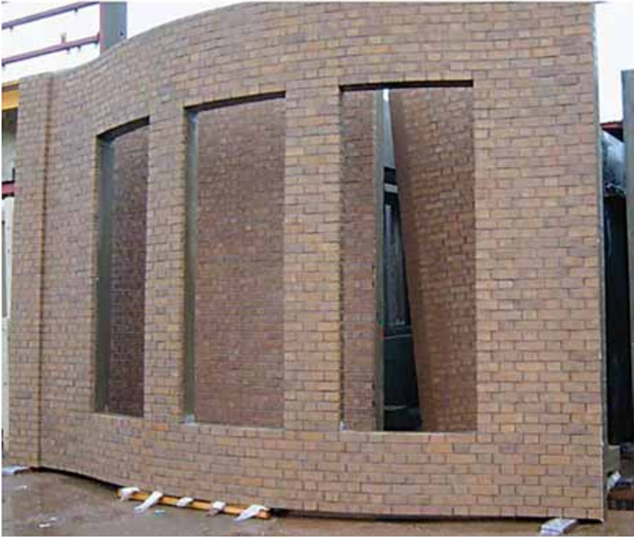
(الشكل 23.1) أشغال أجرٍ مسبق التجميع. الصورة بإذن (Trent Concrete Ltd.).
