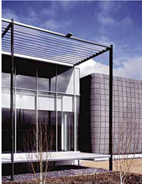
(الشكل 21.3) تغطية خارجية حجرية معادة البناء - مركز بيانات اكسبريان - نوتنغهام. الصورة بإذن (Trent Concrete Ltd.)
