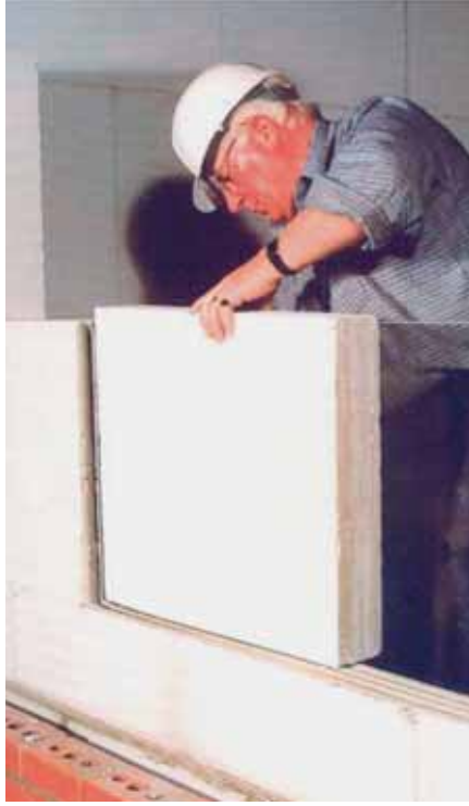
(الشكل 3.2) بناء بوصلات رقيقة باستعمال بلوك بمقاسات كبيرة. أُعيد إنتاج الصورة من (GBG) (58 بالإذن من (BRE) و(Aircrete Products Association).
