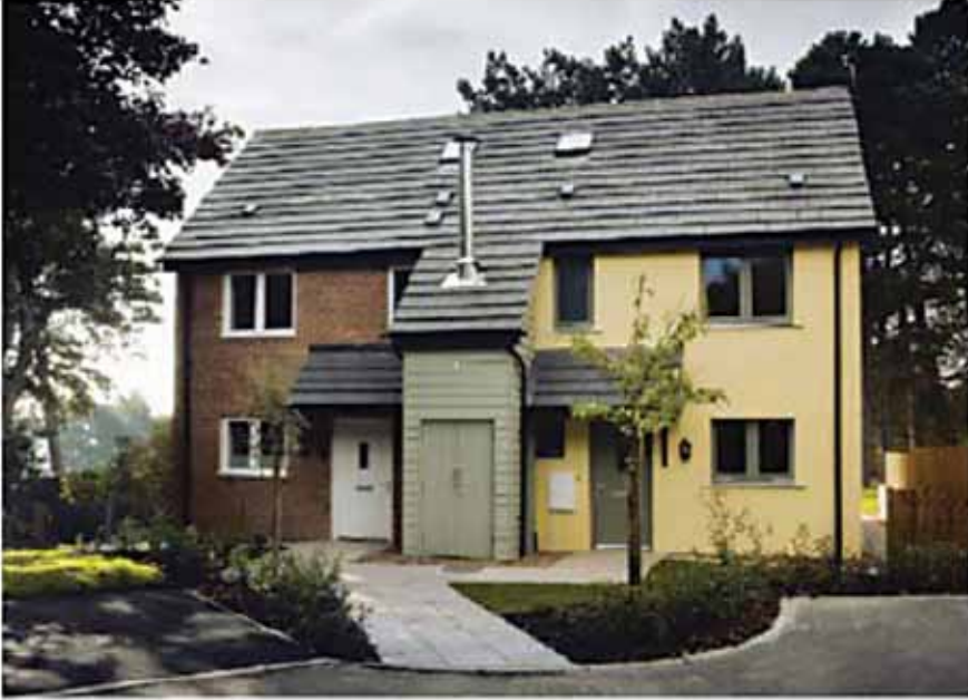
(الشكل 3.18) كود البيوت المستدامة - مشروع بيوت تارماك - جامعة نوتنغهام، زوج من البيوت شبه منفصل، المستوى 6 من الكود (مغطى بالطينة) والمستوى 4 من الكود (أجر). الصورة: الأمامية لمنتجات تارماك للأبنية (Tarmac Building Products) والخلفية لآرثر ليونز (Arthur Lyons).
