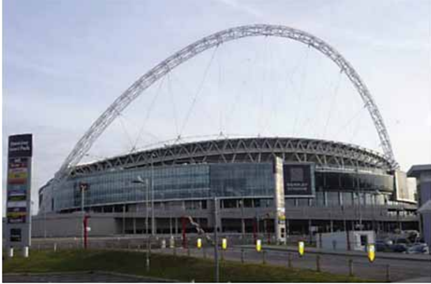
(الشكل 9.5) الأشغال الفولاذية البنوية. ملعب ويمبلي (Wembley) في لندن. المهندسون المعماريون: فوستر (Foster) وشركاه. الصورة: آرثر ليونز (Arthur Lyons).
