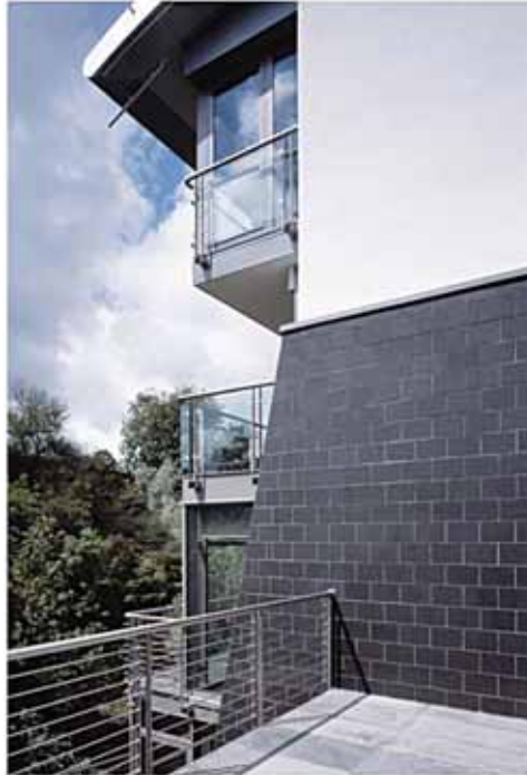
(الشكل 9.2) أشغال بلوك بوجه جميل - مكاتب (IDP)، غلاسكو. المعمار (IDP). الصورة بإذن (Ibstock Brick Ltd.).
