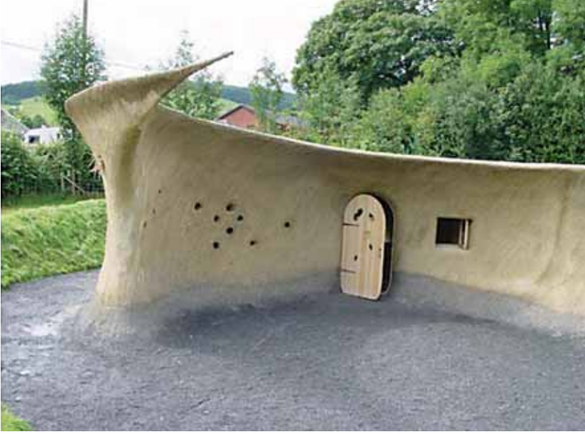
(الشكل 4.17) بناء من الطين والقش - منزل الحكايات، مركز (Bleddfa) للفنون، (Wales, Powys) المعماري، (Tono Mirai) الصورة: ياذن (Richard Weston).
