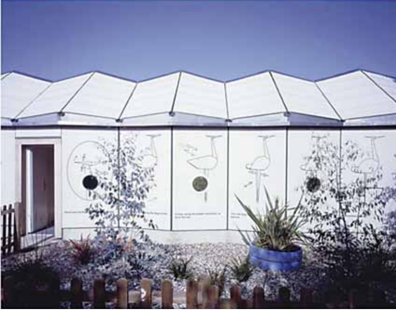
(الشكل 3.17) غرف صف مصنوعة من الكرتون - مدرسة ويستبورو (Westborough)، إسكس (Essex). المهندسون: (Cottrell + Vermeulen). المعماريون (Buro Happold). الصورة : حقوق الطباعة (Adam Wilson/Buro Happold).
