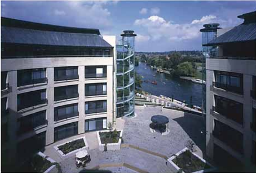
(الشكل 21.9) إعادة بناء الإكساء الصفائحي الحجري - مبنى مياه نهر التايمز في ريدينغ الصورة بموافقة شركة بيتون ترنت المحدودة.
