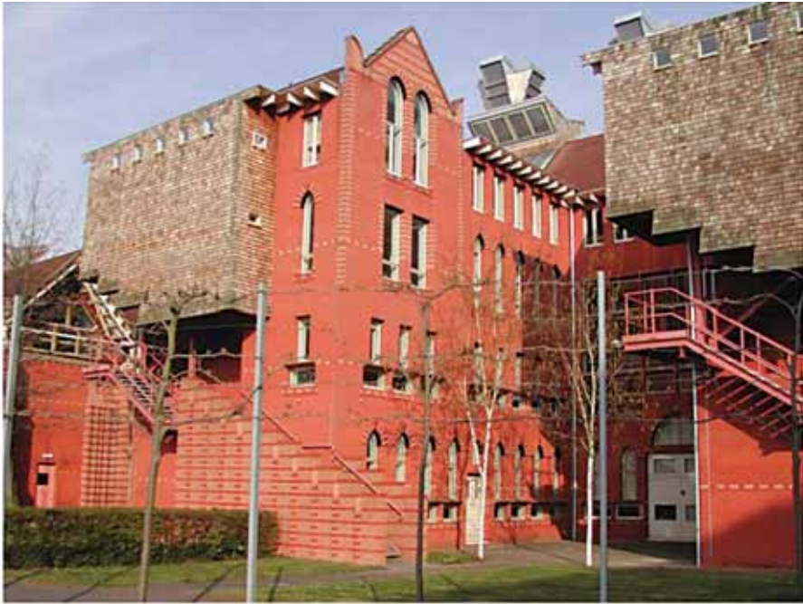
(الشكل 16.1) أشغال أجريّ تزييني - مبنى الملكة، جامعة دو مونثفورت، لايستر. المعمار يون Short (Ford & Associates الصورة: آرثر ليونز (Arthur Lyons)).
