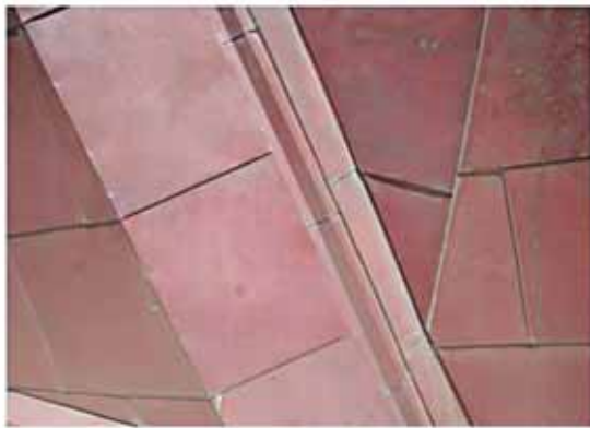
(الشكل 22.5) الإكساء بالنحاس - أجراس برج البجعة، بيرث أستراليا. المعماريون: همس - شيرلي (Hames-Sharley). صورة: آرثر ليونز (Arthur Lyons).
