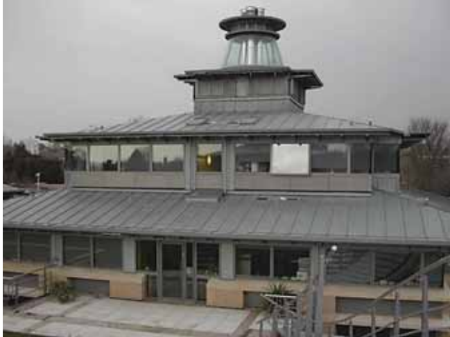
(الشكل 30.5) التسقيف بسبائك الزنك - مركز العلوم الرياضية بجامعة كامبردج. المهندسون المعماريون: إدوارد كولينان (Edward Cullinan). صورة: آرثر ليونز (Arthur Lyons).
