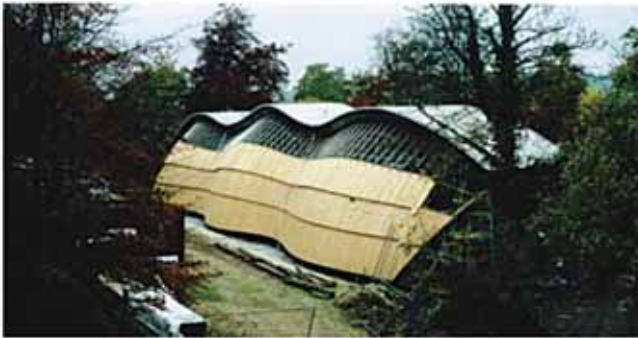
(الشكل 17.4) بناء قشري شبكي - متحف ويلد وداونلند المكشوف (Architects: Edward Cullinan Architects. Photographs: Courtesy of Edward Cullinan Architects)
