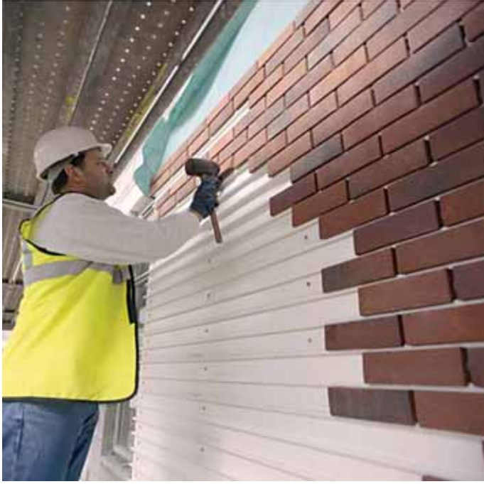
(الشكل 24.1) منظومات إكساء الأجر. الصورة بالإذن من (Courtesy of Corium, a division of Baggeridge Brick Plc.)
