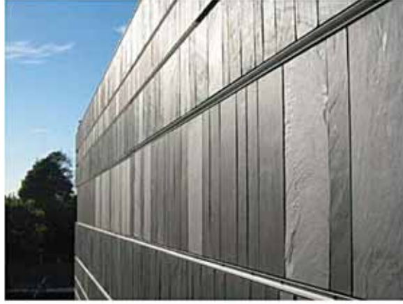
(الشكل 20.3) تغطية خارجية خرسانية مسبقة الصنع مغطاة بشرائح الأردواز، متحف سوانزي. الصورة بإذن (Trent Concrete Ltd.)
