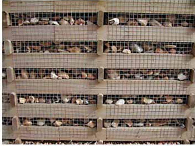
(الشكل 16.9) نظام سند التربة من الخشب والشبك والحجارة.
