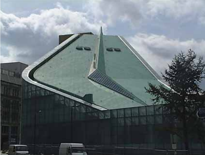
(الشكل 23.5) أعمال تشييد السقف بالنحاس - مركز أربيس (Urbis) في مانشستر. المعماريون: ايان سمبسون (Ian Simpson). الصورة: ياذن من كريس هودسون (Chris Hodson).
