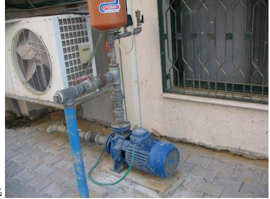
شكل مضخة المياه الرئيسية
