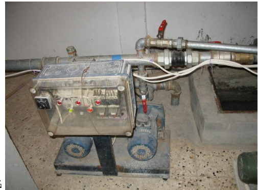
شكل مضخات المياه مع لوحة التحكم
