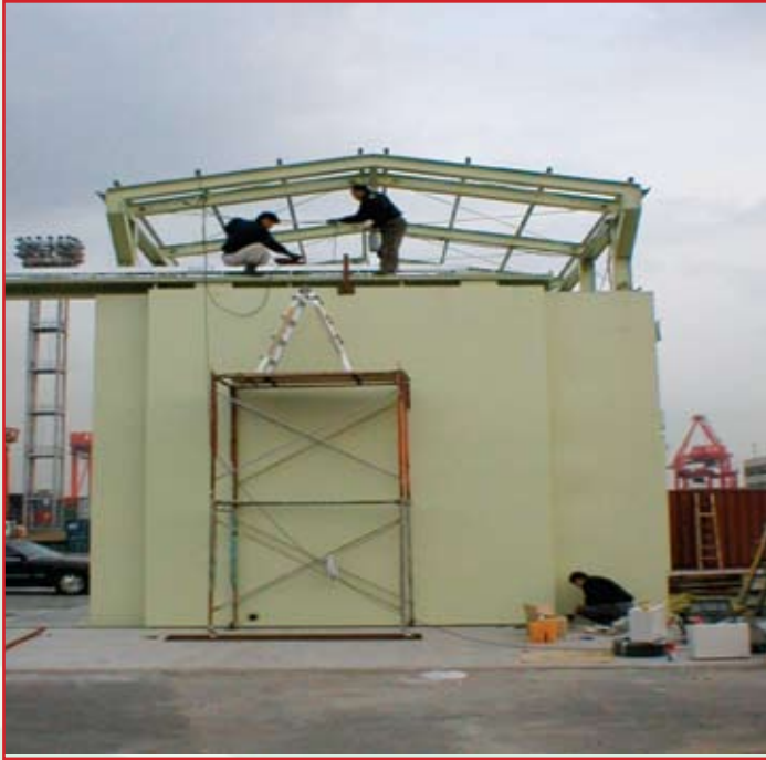
محطة كشف بالأشعة من النوع القابل للفك وإعادة التركيب
