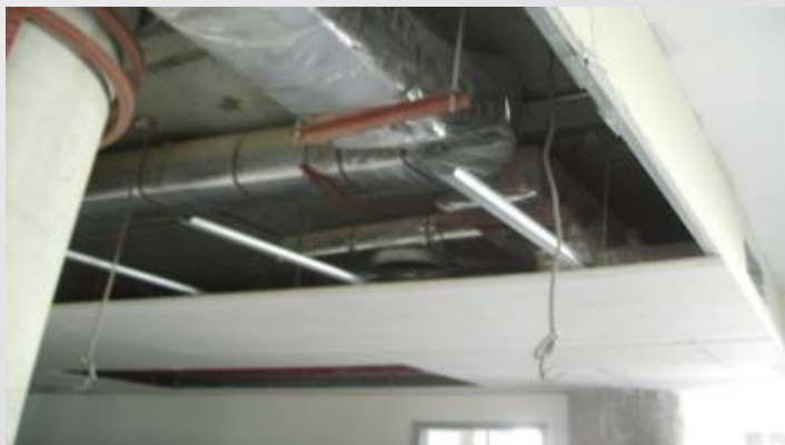
اخفاء التركيبات الخاصة باعمال التهويه والاضاءة
