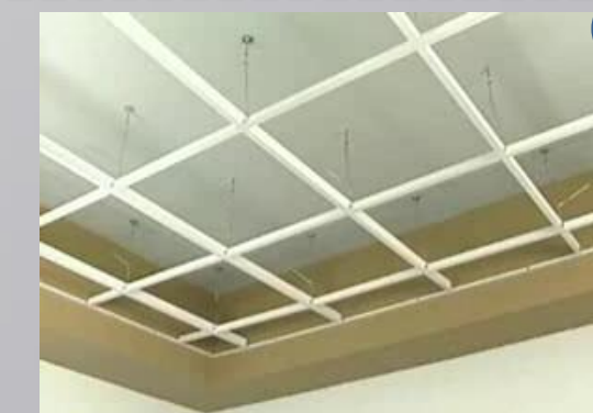
بعد تركيب الكمرات الرئيسيه و الثانويه تظهر بهذا الشكل و يتم تركيب خدمات الاضاءه و التكييف
