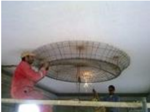
صورة توضح تثبيت أسياخ الحديد
