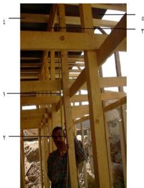
شكل رقم ( ٤١ ) يبين استخدام شريط الشياس لتحديد منسوب العرقات من نقطة الشرب
