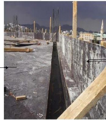
شكل رقم ( ٢٤ ) يبين ارتفاع الدائر بالنسبة لمستوي التطبيق
