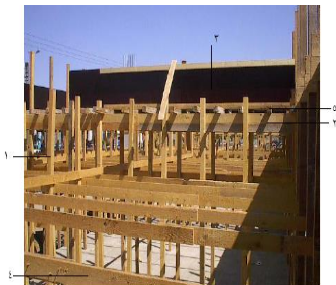
شكل رقم ( ٤٠ ) أعمال التخشب للكمـرات مع عمل البراندات لتثبيت القوائم
