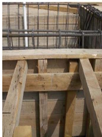
شكل يبين لوح الزنق في جنب الكمرة
