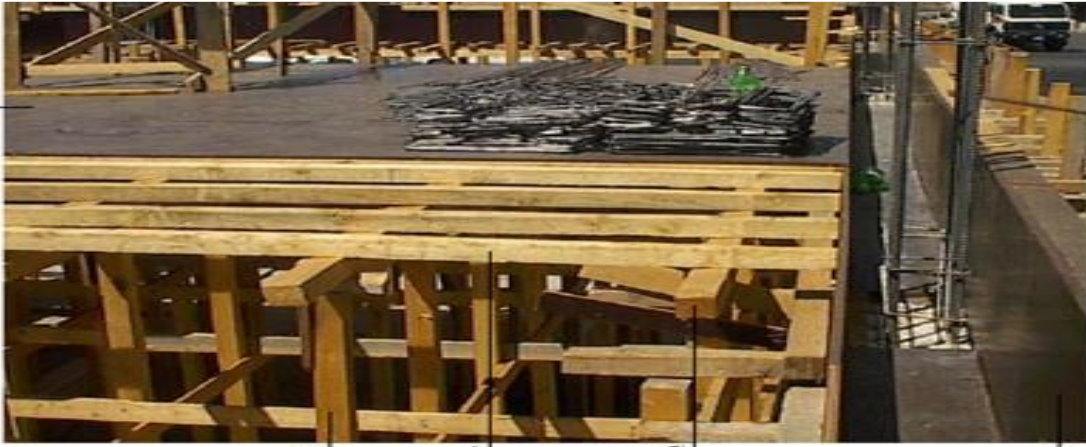
شكل رقم ( ٤٣ ) يبين بدء عملية التطبيق للسقف تمهيدا لعمليات الحدادة
