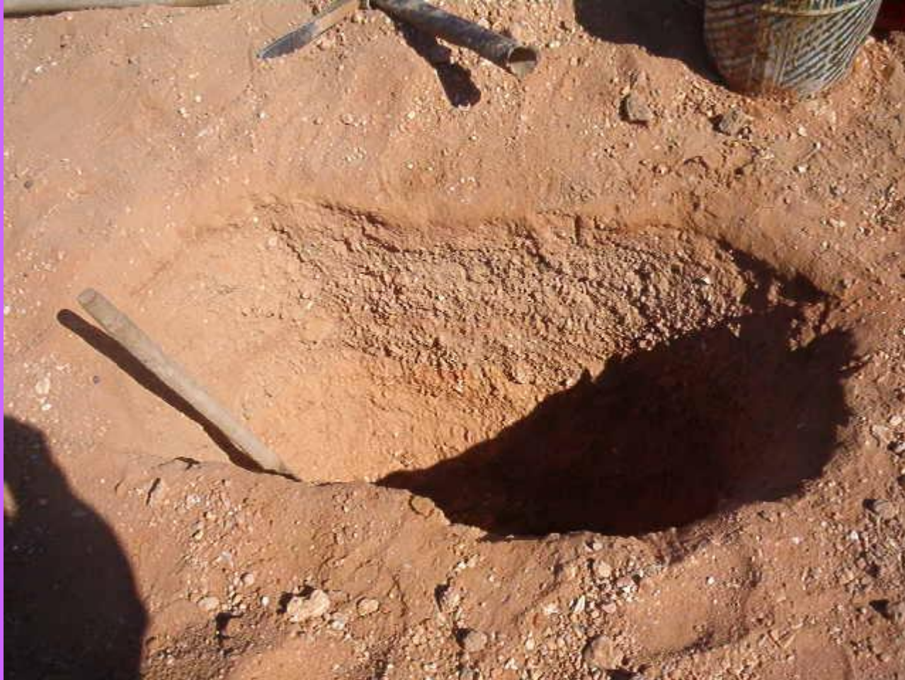
حفر الاختبارات المكشوفة Test Pits and Open Cuts
