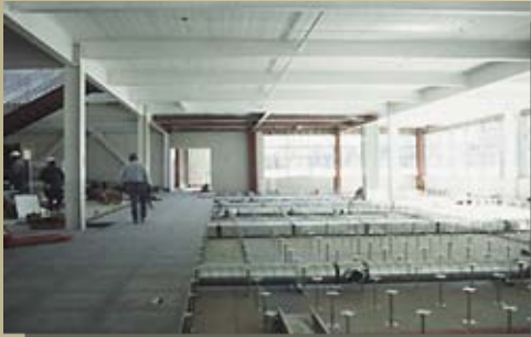
صورة للشاسبيات و عليها الشدادات الموصلة بين كل شاسبيه و لآخر
