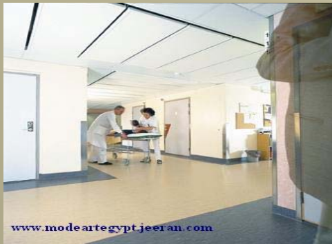
الأرضيات انفينيل اعازنة للكهرباء "انتيساتيك"
