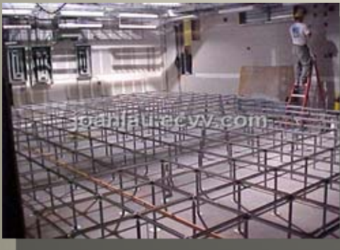
صورة للشاسبيات و عليها الشدادات الموصلة بين كل شاسبيه و لآخر
