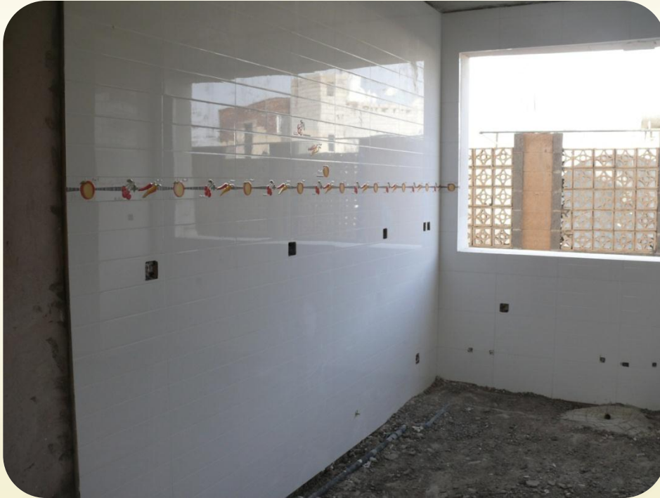
صوره توضح توزيع مواسير التغذية داخل المطبخ ( بعد التبليط )
