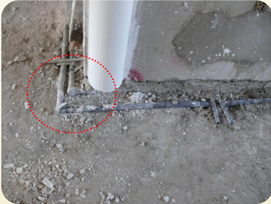
صوره توضح مواسير تغذيه المياه الساخنة إلى حمامات و مطابخ الشقة
