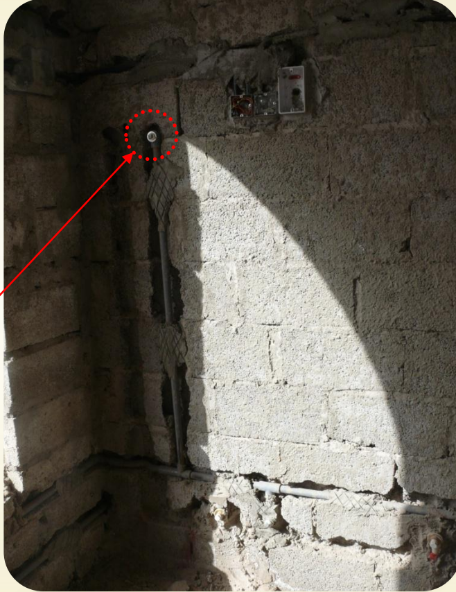
صوره توضح توزيع المياه الباردة داخل الحمام
