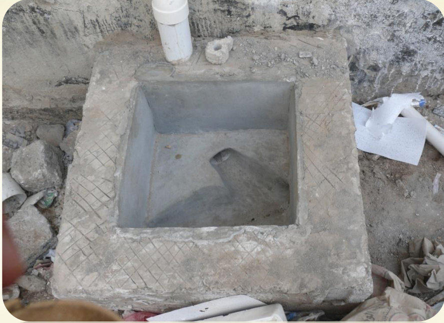
صوره توضح غرفه التفتيش الخاصة بالمواد الصلبة
