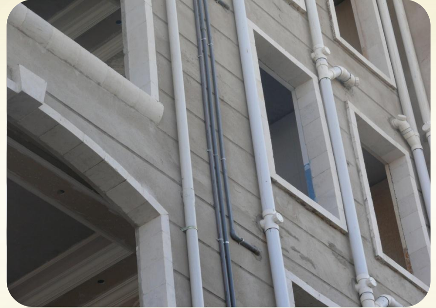
صوره توضح مواسير التصريف الخاصة بالمواد الصلبة المتجه إلى المجاري العامة ومواسير تصريف المواد السائلة المتجه إلى خزان التكرير.
