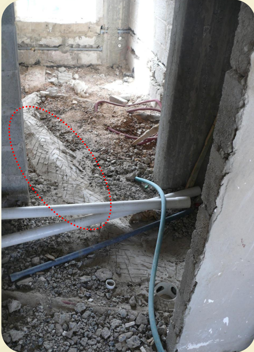
صورة توضح خط تصريف المواد السائلة المتجه إلى الحمام
