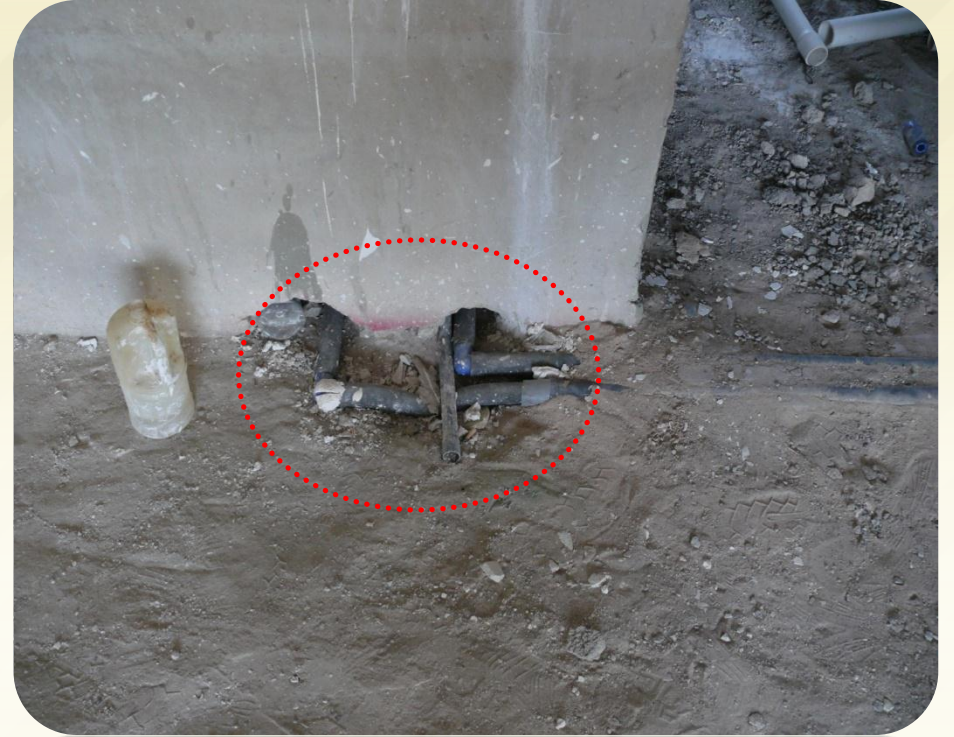
صوره توضح خروج مواسير تغذيه المياه الساخنة إلى حمامات و مطابخ الشقة
