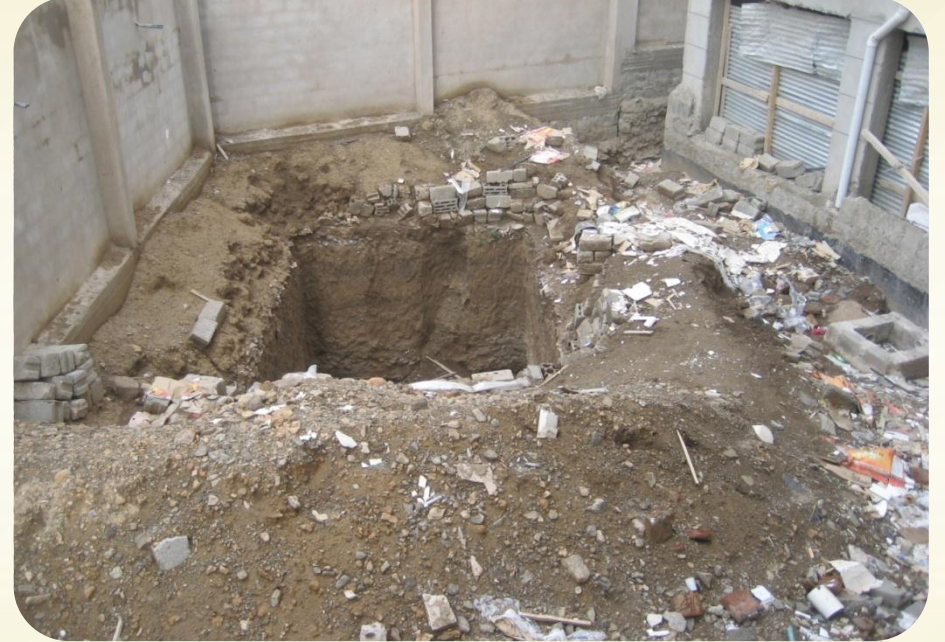
صوره توضح مكان خزان التكرير وبعد ذلك يستخدم في عمليه ري النباتات
