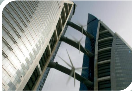
برجي التجارة العالمي (البحرين) هذه المراوح تزود البرج ب 15% من احتياجاته الكهربائية
