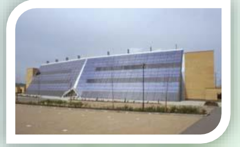
صورة تبين استخدام الخلايا الفوتوفولتية في الواجهات
