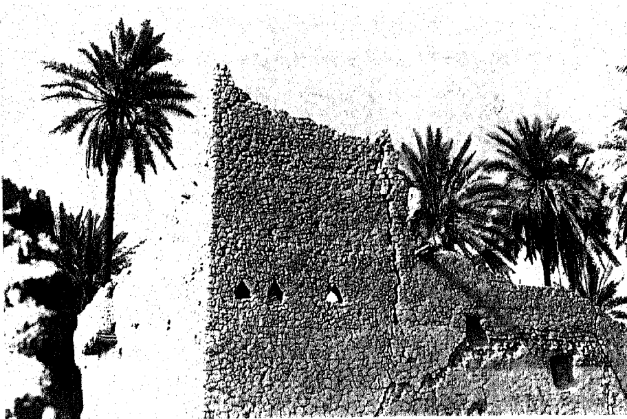
● المباني الطينية القديمة تعانق أشجار النخيل الباسقة.
