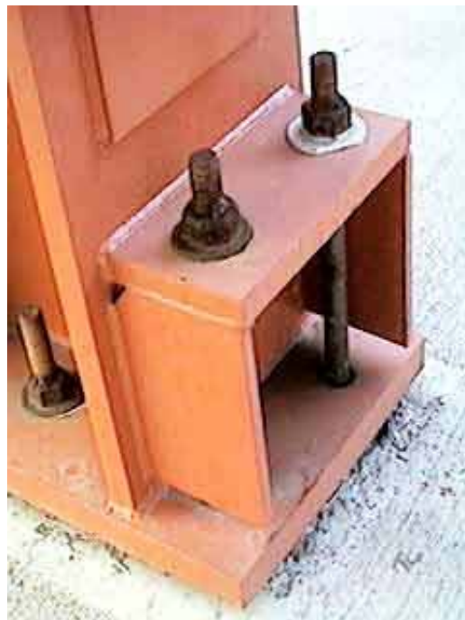
الشكل 7.2 : قاعدة عمود فولاذي
